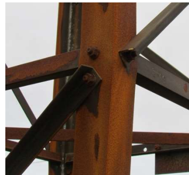
Mynd 3.1 Samanburður á ryðmyndun frá 2002 til 2013 á leggjárn í mastri 208 í KH1 (BU2). Veruleg aukning á ryði. Umrætt mastur stendur norðan við Suðurlandsveg á miðri Hellisheiði.
