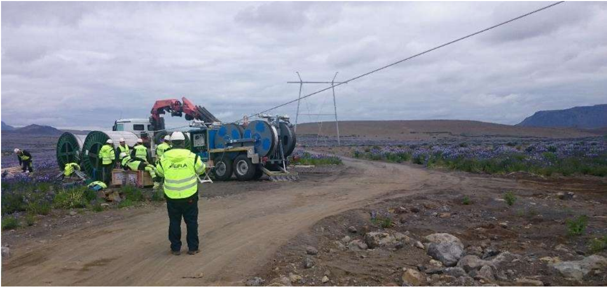
Mynd 4.6 Strenging leiðara. Myndin er frá byggingu Kröflulínu 4.
