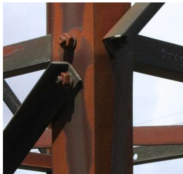
Mynd 3.1 Samanburður á ryðmyndun frá 2002 til 2013 á leggjárn í mastri 208 í KH1 (BU2). Veruleg aukning á ryði. Umrætt mastur stendur norðan við Suðurlandsveg á miðri Hellisheiði.
