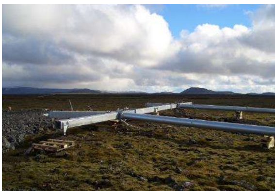
Mynd 4.5 Myndir sýna vinnu við samsetningu og reisingu stagaðs burðarmasturs af M-gerð með jarðvírseyrum. Myndirnar eru frá byggingu Reykjaneslínu 1.
