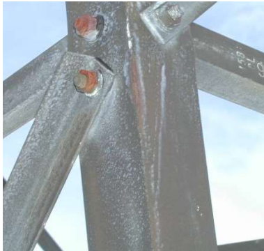
Mynd 3.1 Samanburður á ryðmyndun frá 2002 til 2013 á leggjárn í mastri 208 í KH1 (BU2). Veruleg aukning á ryði. Umrætt mastur stendur norðan við Suðurlandsveg á miðri Hellisheiði.
