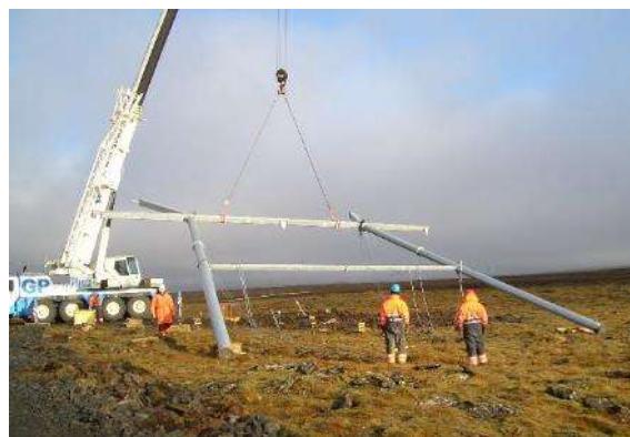
Mynd 4.5 Myndir sýna vinnu við samsetningu og reisingu stagaðs burðarmasturs af M-gerð með jarðvírseyrum. Myndirnar eru frá byggingu Reykjaneslínu 1.
