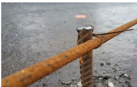
Dæmi um járnabindingu fyrir vélsteyptan kantstein
