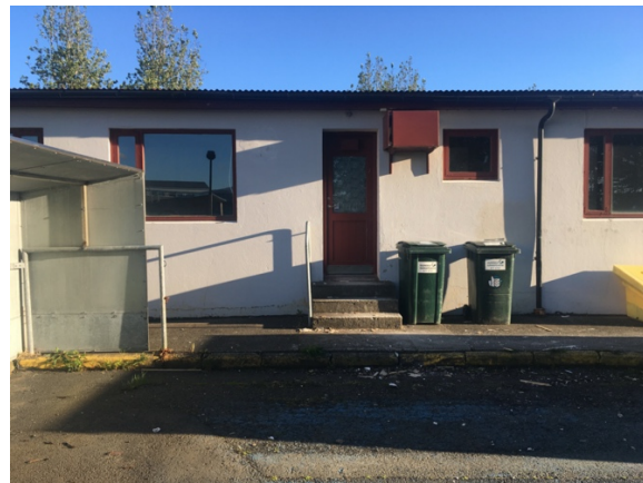
Núv. steypur tröppur við eldhús.
