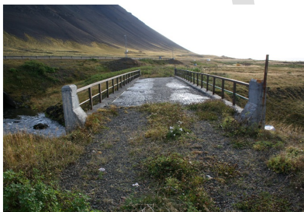
Mynd 63. Brú (1896-93) yfir Ártúnsá frá 1946, horft í suðaustur.
