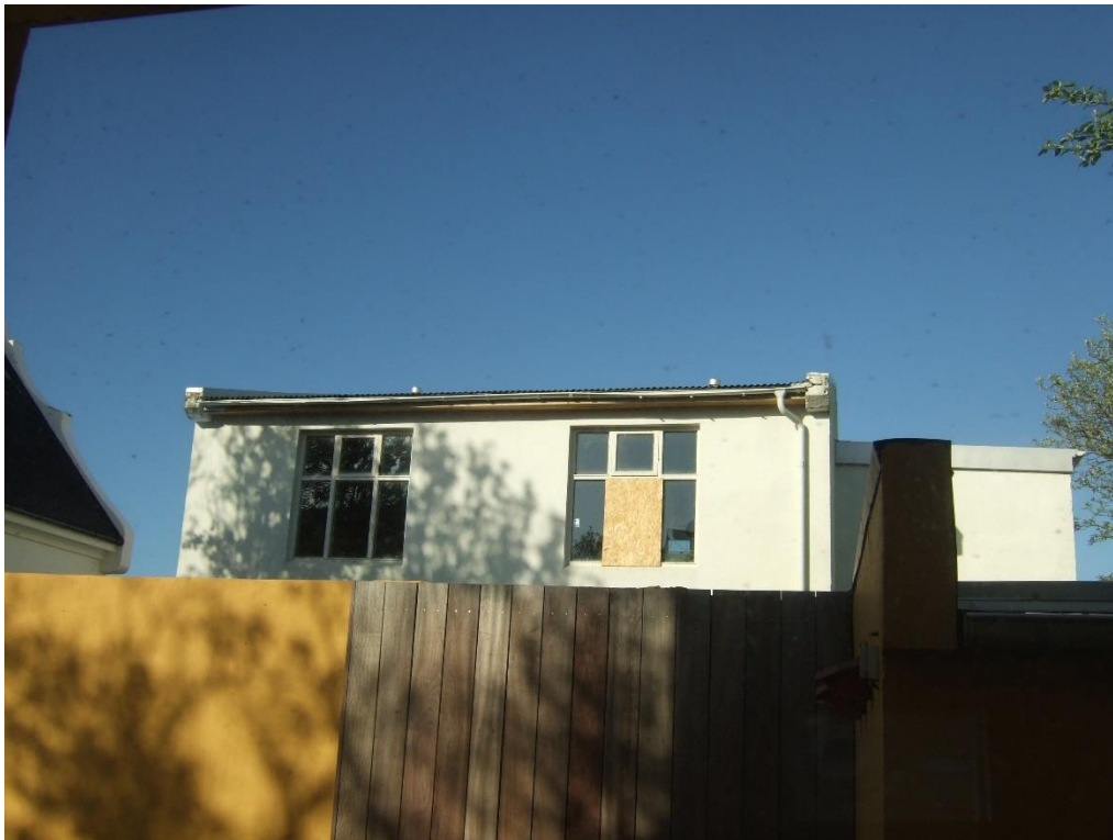
2. mynd. Útsýni úr gluggum húseignar að Lokastíg 15 mun skerðast verulega við hækkun húseignar að Skólavörðustíg. Þessi mynd sýnir núverandi útsýni frá eldhúsi á neðri hæð Lokastígs 15.
