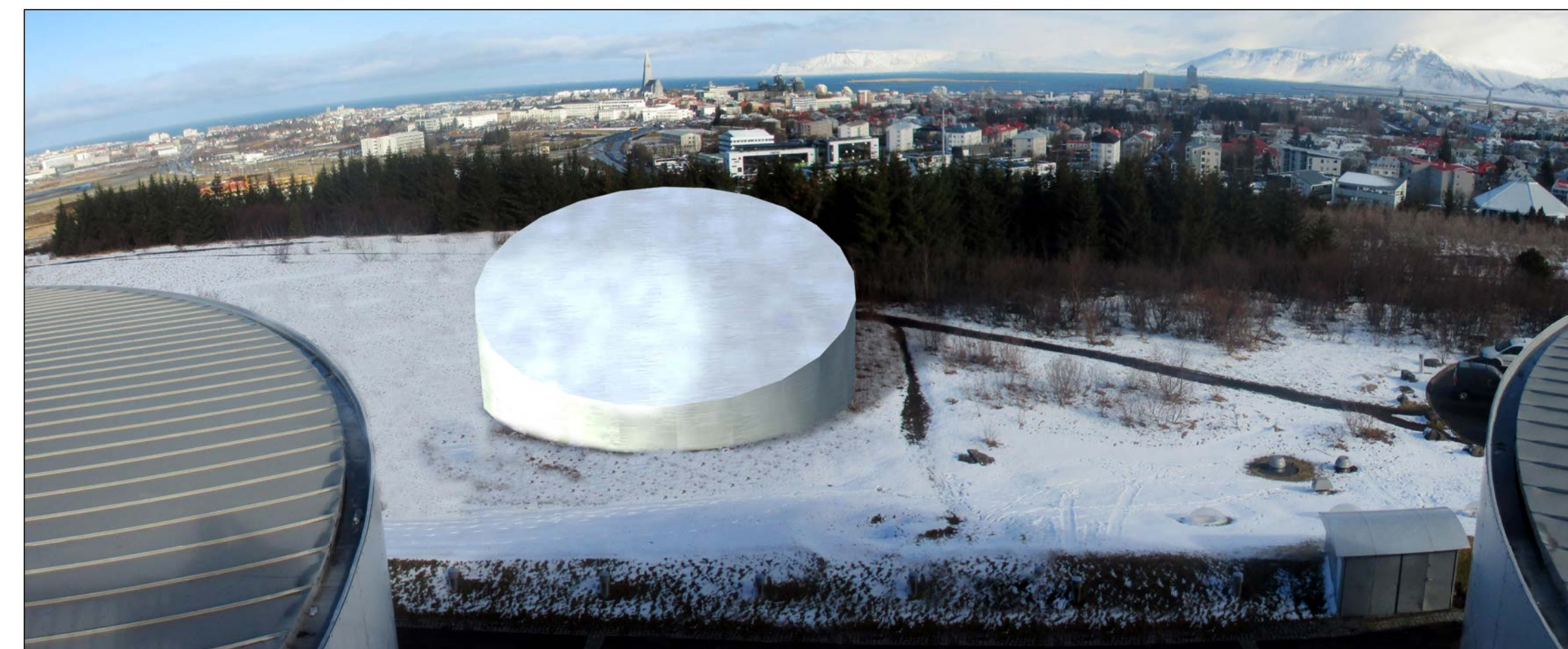
Skýringarmynd 5 sýnir það útsýni sem gestir útsýnissvæðis Perlunar munu hafa yfir áætlað Planetarium en inngangur þess verður neðanjarðar frá Perlunni.
