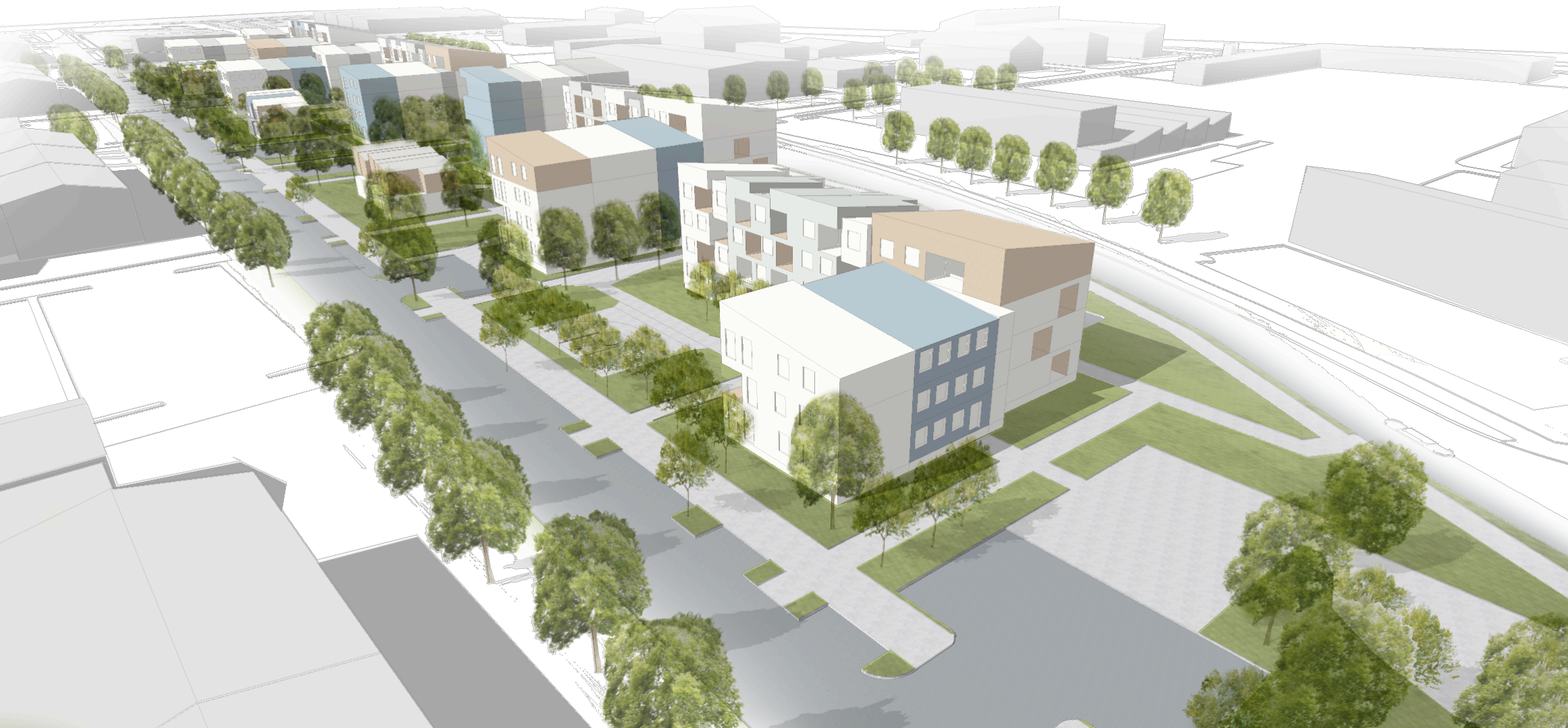
Horft yfir íbúðabyggðina úr suðaustri
