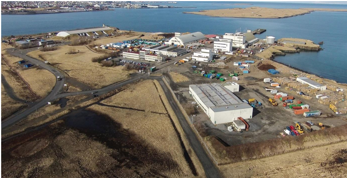
5. mynd. Núverandi byggð í Gufunesi. Fyrirhuguð endurskipulagning tekur einkum til núverandi atvinnulóða og nærliggjandi svæða sem hefur verið raskað.
