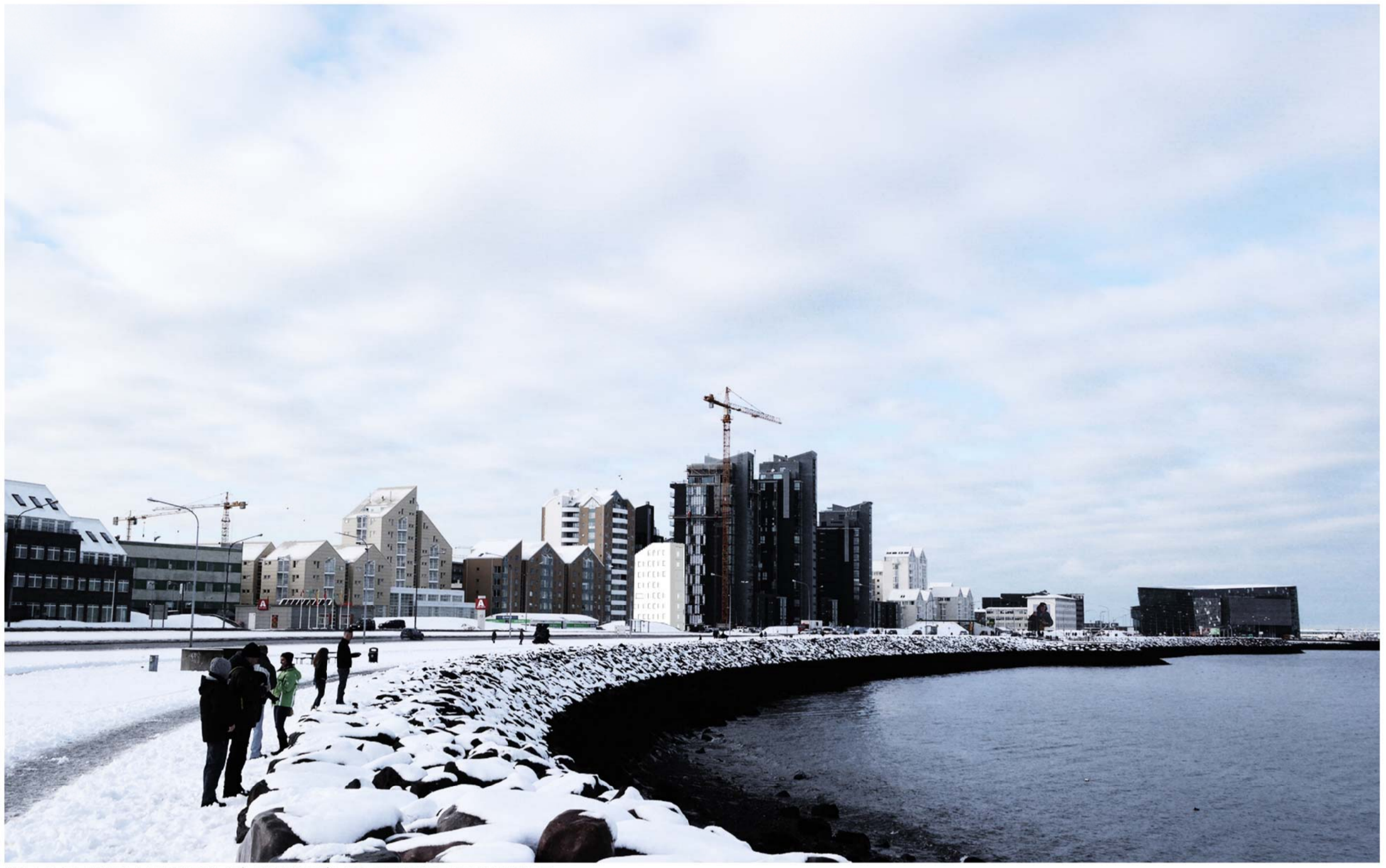
HORFT AÐ SKIPULAGSSVÆÐI FRÁ GÖNGUSTÍG VÍÐ SÆBRAUT AUSTANVERT.
