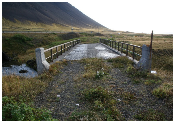
Mynd 107. Brú (1896-93) yfir Ártúnsá frá 1946, horft í suðaustur.
