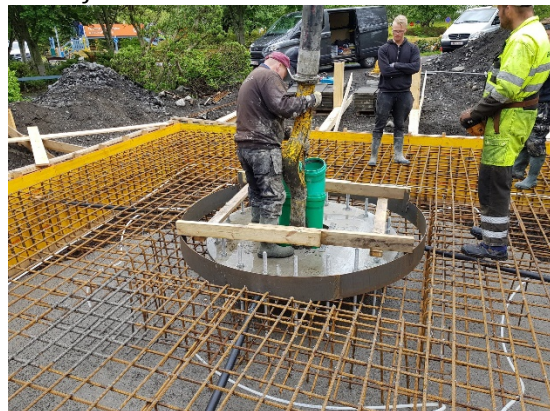
50 m3 af steypu
