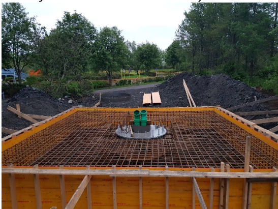
Járnbending og lagnir í undirstöðu
