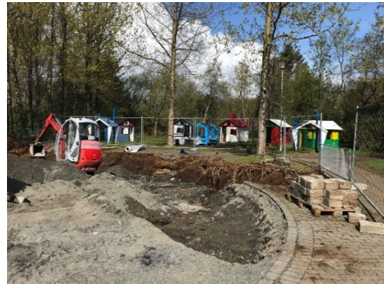
Jarðvegsskipti og drenlög
