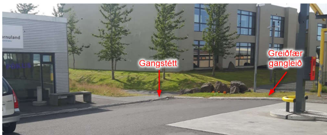
Mynd 10. Frá Ingunnarskóla liggur gönguleið milli gangstígs og gangstéttar framan við verslunarmiðstöð. Æskilegt væri að beina umferð gangandi vegfarenda um þessa gönguleið með því að takmarka aðgengi um leiðina til hægri gegn um afgreiðsluplanið.
