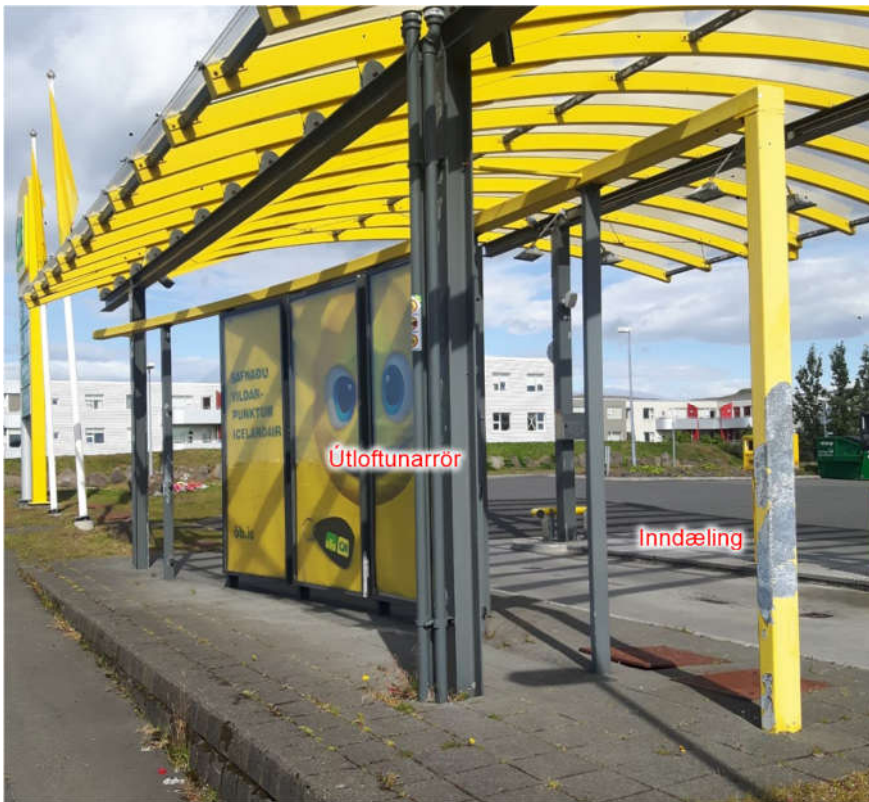
Mynd 4. Inndæling og útloftunarrör.
