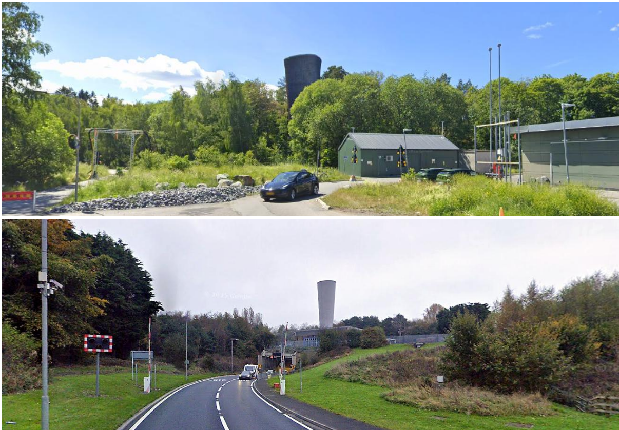
Mynd 8.60 Dæmi um útlit loftunarturna við göng. Á efri myndinni er loftunarturn við Norra Länken göngin í Stokkhólmi í Svíþjóð, en neðri myndin er við göngin sem liggja undir ána Tyne í Newcastle á Englandi. Báðar myndirnar eru unnar eftir Google Street View.
