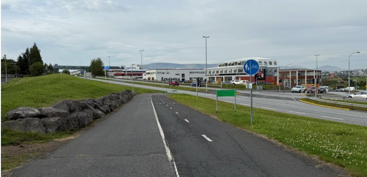
Mynd 8.34 Núverandi göngu- og hjólaleið yfir Sæbraut við Súðarvog, séð frá suðvestri. Lengst til vinstri glittir í göngu- og hjólastíg meðfram og vestan við Sæbraut og ný tímabundin göngubrú ber við himin.
