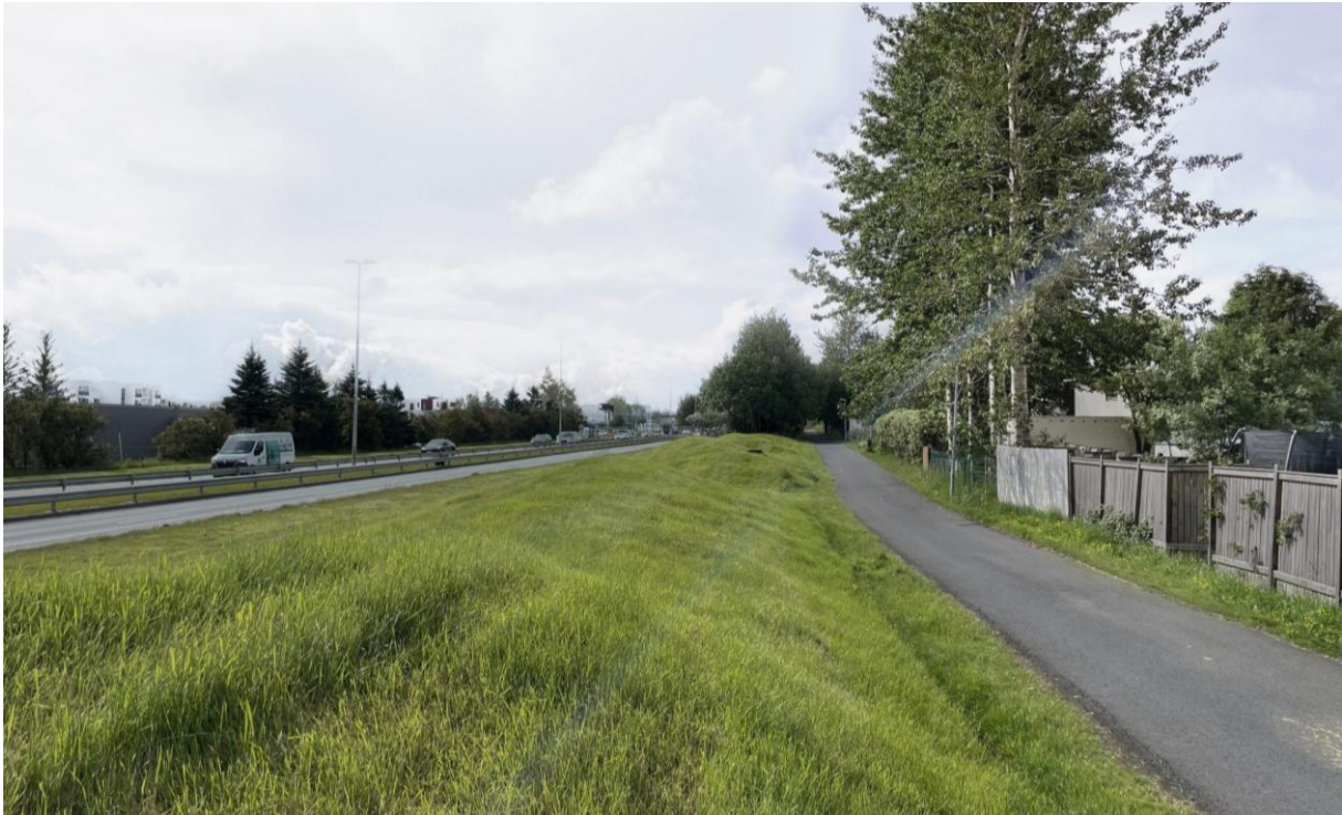
Mynd 8.17 Núverandi ásjón umhverfis Sæbrautar, séð frá göngustíg sem liggur meðfram Sæbraut, móts við Dreka­vog. Horft er til suðurs að gatnamótum Sæbrautar við og Kleppsmýrarveg/Skeiðarvog, en fjær sér í Vogabyggð.
