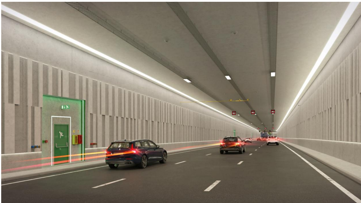
Mynd 4.8 Mögulegt útlit innan í stokk með ljósum, loftblásurum (í fjarska), neyðardyrum á milli hólfa og öðrum öryggisbúnaði, s.s. neyðarsíma og slökkvivatnsstútum við flóttaleið, myndavél og hraðamyndavélum (gular).
