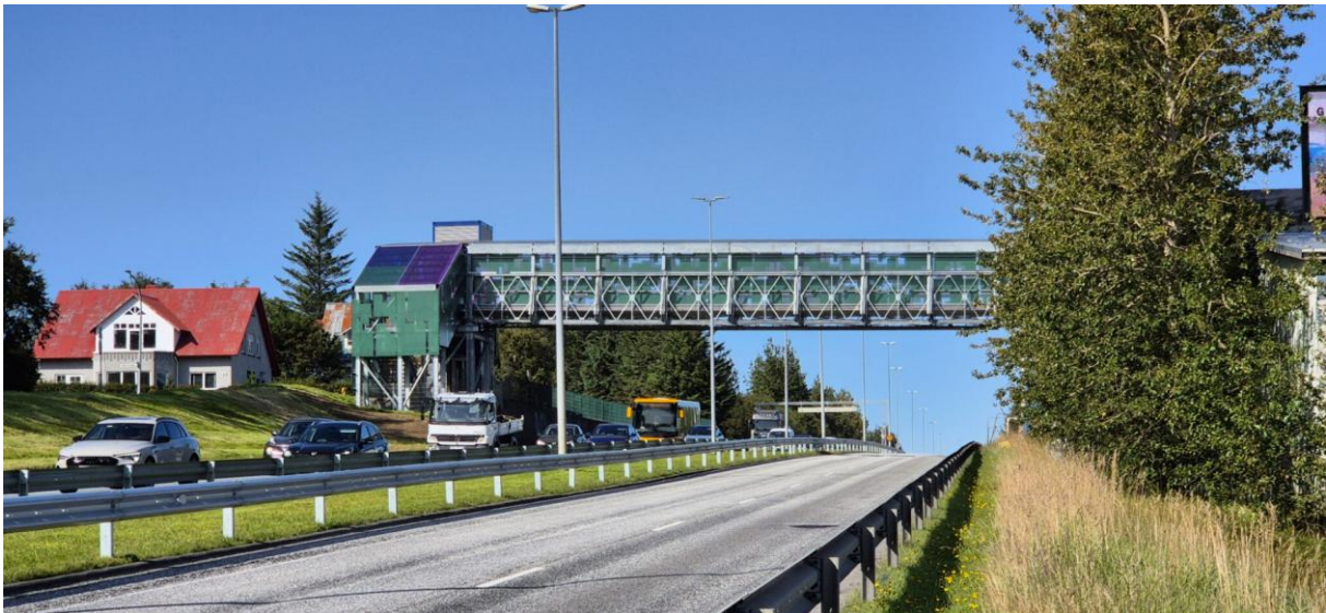
Mynd 4.2 Búið er að setja upp göngubrú yfir Sæbraut á mótis við Snekkjувog sem verður færð til á framkvæmdatíma og tekin niður þegar bílaumferð er komin í stökkinn. 30
