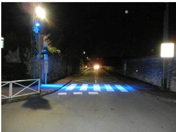
Gangbrautarlýsing í Frakklandi
