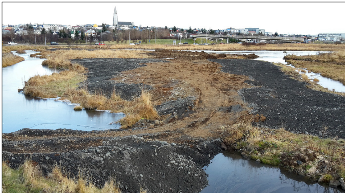
6. mynd. Framkvæmdir í friðlandinu í Vatnsmýri 4. nóvember 2018. Ljós. ÓKN.
