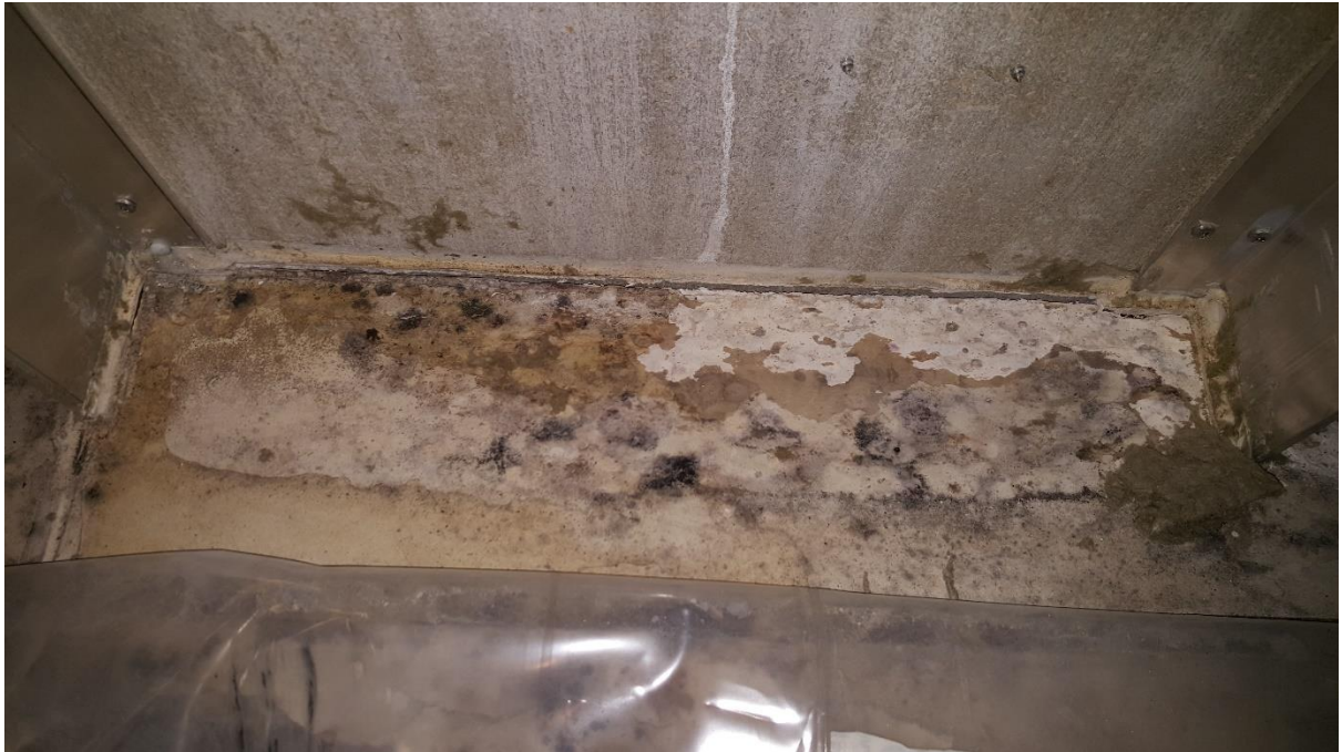
Mynd 9 Hér má sjá dæmi um rakaskemmdir á gipsplötu og Viroc í útvegg.
