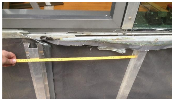
Mynd 42: Á mynd sjást útlit og frágangur á miðjuleiðurum. Ummerki eru um opin skrufugöt undir þessum leiðurum eftir enduruppsetningu klæðningar.
