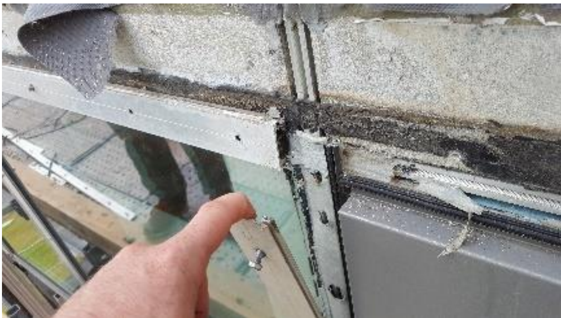
Mynd 5 Þéttibönd undir pressulistum eru víða mjög götött eða rifin eftir skrúfur. Ummerki voru um að vatn komist inn undir listana inn um götin og drenist síðan ekki út úr kerfinu.
