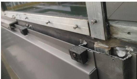
Mynd 41: Á mynd má sjá frágang á festingum og leiðurum undir áklæðningu á austurhlið. Plastkubbar eru í flestum tilfellum lausir á endaleiðurum.
