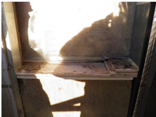
Mynd 23 Dæmi um brunaloku á hæðarskilum. Greinileg mygla er til staðar.
