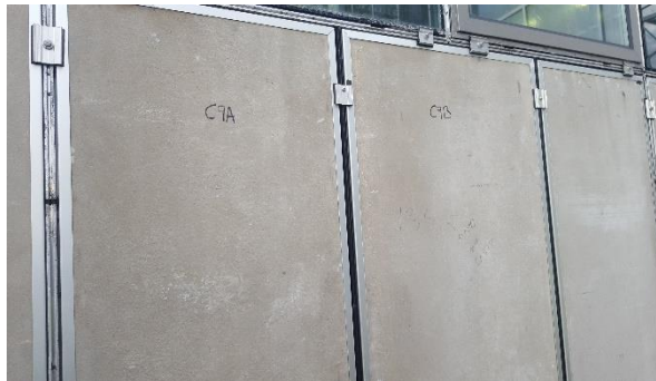
MYND 3 Ófrágengin útveggur.
