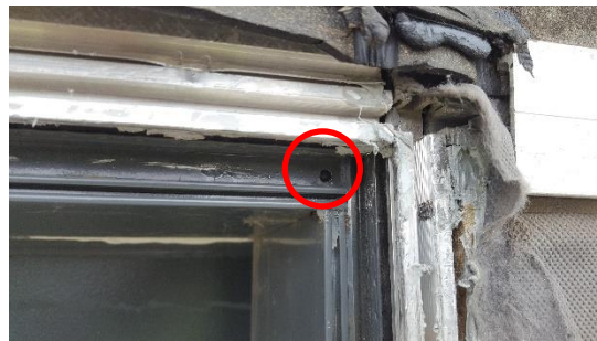
Mynd 30 Dæmi um opið gat úr drenrás láréttis prófils og inn í innri hluta álprófilsins. Loft getur hæglega dregið með sér vatn inn í prófílinn.
