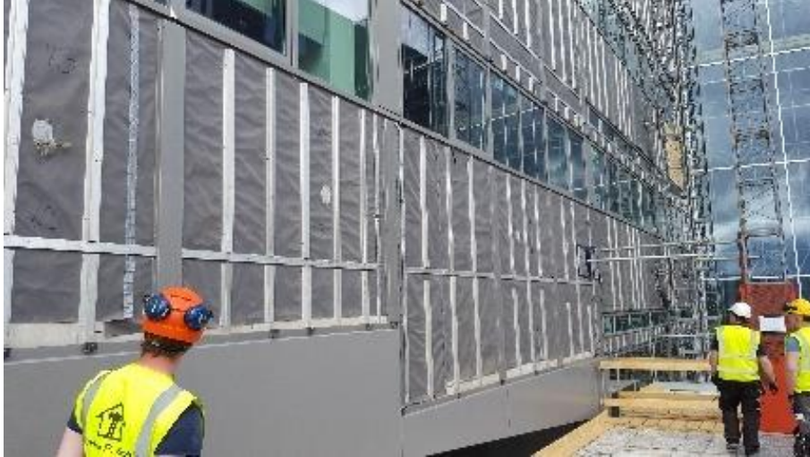
Mynd 1 Mynd frá rannsóknarviðgerð (rautt svæði) á austurhlið hússins þar sem unnið var að rannsóknum og endurbótum á ytra byrði hússins. Settar voru upp stórar vinnulyftur til að vinna að verkinu.
