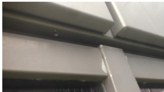
Mynd 40: Víða má sjá flögnun málningar á glerlistum á gluggum. Ekki er vitað um ástæðu fyrir þessu en líklega er undirvinna ekki nægjanlega vönduð.
