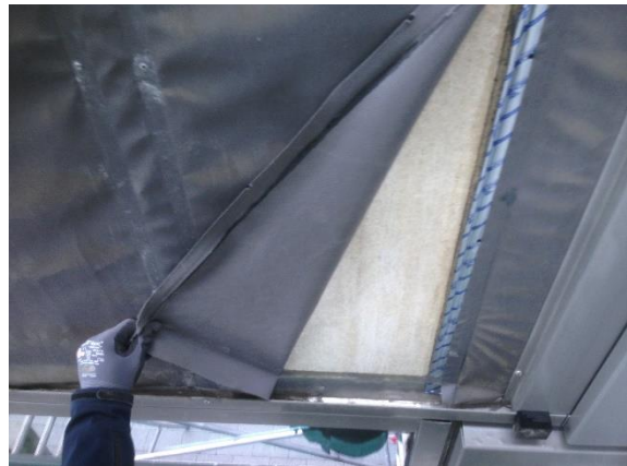
Mynd 10: Á suðurhluta austurhliðar er dúkur sem notaður er sem vatnsvörn undir álklæðningu til þetta útvegi hússins fyrir vatns og veðurálagi. Dúkur hindrar þó ekki að vatn fari inn í gluggaföls.
