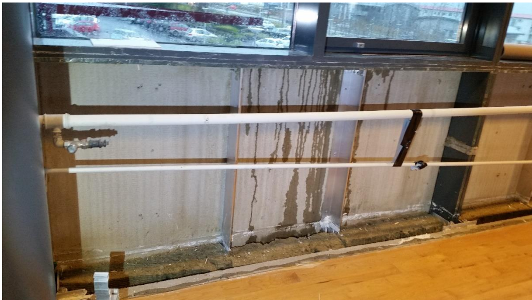
Mynd 14: Á mynd sem er tekin innanhúss af gluggakerfi á suðurhluta austurhliðar á 2. hæð mál sjá leka úr gluggafalsi meðfram sementsbundnum trefjaplötum. Plötur eru stuttar og ná ekki nægjanlega vel upp á þéttilista í gluggafalsinu og því lekur inn þegar vatn safnast fyrir í falsinu. Á mynd má sjá að miðjupóstur endar á láréttum pósti og því er drenleið löng að næsta lóðréttu pósti. Innan á trefjaplötum eru lóðréttir styrktarvinklar en að utan er grindarkerfi fyrir álklæðningu. Á nokkrum stöðum eru opin göt í plötum eftir grindarkerfi og rakasmit inn um þau. Á mynd má sjá að á skoðunarstað er búið að fjarlægja rakaskemmda og myglaða eldvörn (gifsplötur) á milli hæða.
