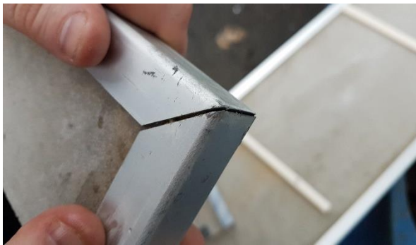
Mynd 9 Samskeyti U-skúffu heldur óþétt. Ekkert kitti sýnilegt við horn plötunnar.
