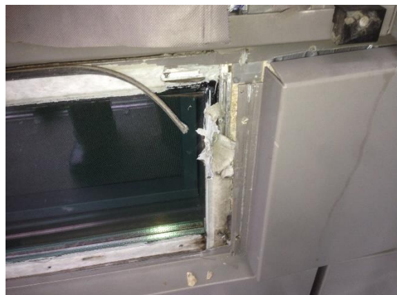
Mynd 12: Við nánari skoðun á þéttingum og frágangi gluggakerfi mátti sjá að þéttiborðar og kítisfrágangur er með þeim hætti að vatn getur lekið inn í gluggakerfið en ekki komist út úr á eðlilegan hátt og orsakað þannig leka innanhúss. .
