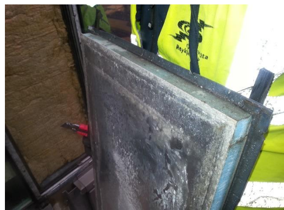
Mynd 20: Álplötur á milli glugga eru hefðbundnar samlokueiningar með álplötum á sitt hvoru yfirborði og plasteinangrun á milli. Bleyta var ofan á plötu en engin augljós drenun út úr gluggafalsi á þessum stað.
