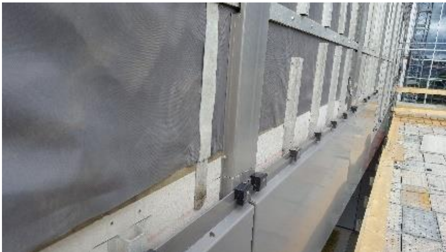
Mynd 2 Mynd sýnir rannsóknar- og prófanasvæði á austurhlið hússins þar sem áklæðning var tekin af húsinu og uppbygging útveggjarins skoðuð. Sjá má festingar á áklæðningu og vatnsvarnardúk þar undir.
