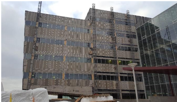
MYND 2 Útveggur í vinnslu.
