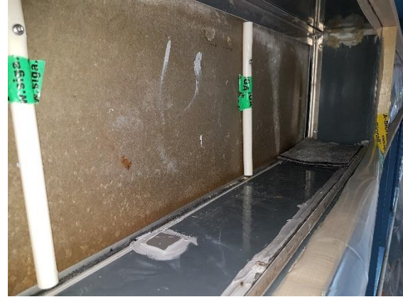
Mynd 26 Rakapétting á yfirborði Viroc plötu þegar bil var opnað
