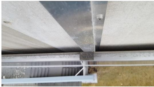
Mynd 33 Dæmi um 3,0mm milliprófíl. Ekki er sambærilegt los og í 2,0mm efninu.
