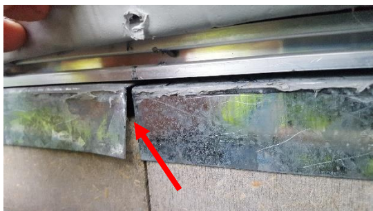
Mynd 31 Dæmi um algenga sjón þar sem Viroc plötur eru of stuttar og ákveðið hefur verið að hækka þær með U-skúffu úr blikki til að pressuplötur fái eitthvað sæti. Auðvellega getur lekið með slíkum samsetningum. Einnig sést opin rauf milli Viroc platna þannig að lekið getur inn.
