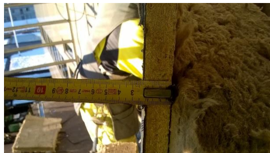
Mynd 24 Viroc plata reyndist vera u.þ.b. 20mm. Þegar pressuplata er klemd að 26mm gleri og 20mm Viroc plötu er mjög líklegt að þétting verði léleg.
