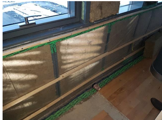
Mynd 30 Rakavörn sveitt á inni hlið vegna rakastreymis í útvegg. Sólarálag var mikið þennan dag. Svipuð staða var undir öllum gluggum 6 hæðar suður þegar mynd var tekin
