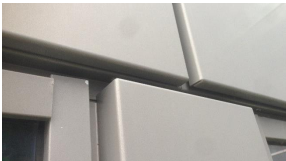
Mynd 39: Á mynd má sjá laust állök á glerlista en þetta má sjá á nokkrum stöðum á húsinu. Ekki er hætta á leka en getur valdi skaða ef hann dettur.
