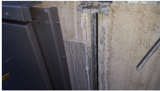
Mynd 34 Taumar utan á Viroc klæðningu benda til þess að mikið vatnsálag sé á klæðningunni, jafnvel undan megin rigingaráttum. Viroc klæðning er samsett og léleg þétting er milli platna.
