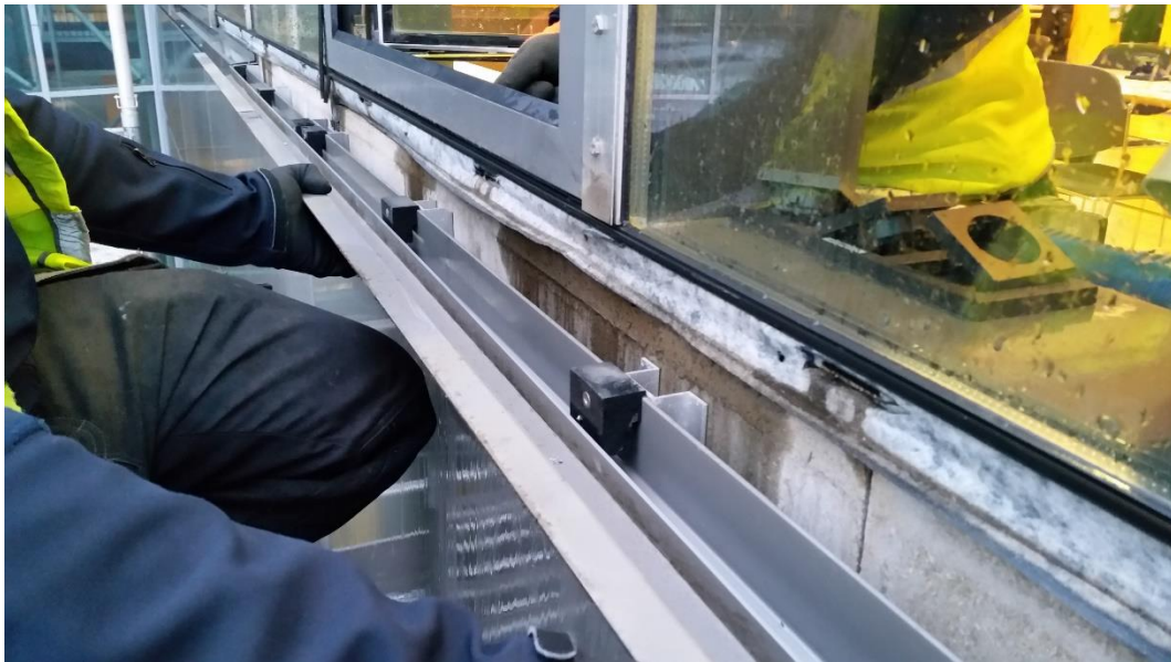
Mynd 21: Gluggakerfið var skoðað á 3. hæð á norðurhluta austurhliðar. Þéttiborðar eru yfir gluggafölsum en ná ekki vel niður á VIROC plötur sem eru of stuttar og ná varla upp á þéttalista í gluggafalsi. Vatn safnast inn í gluggafalsi og á ekki greiða leið út þar sem drenleiðir eru langar. Engin sjáanleg drenun er hugsuð út gluggafalsi önnur en drenun undan gleri. Sjá má mikinn raka úr falsi og utan á VIROC plötum á móts við lóðréttan póst og lekastað innanhúss.
