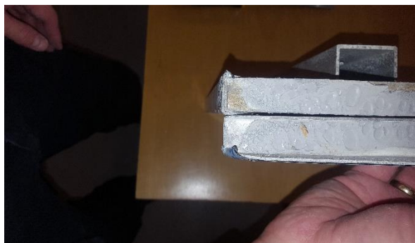
Mynd 14 Kíttisþétting er heldur þunn í þessari skúffu og sjá má að engin kíttisþétting er í hornum þar sem mestu líkur eru á loftleka inn í kerfið. Ekki lokaður endi á plötunni.
