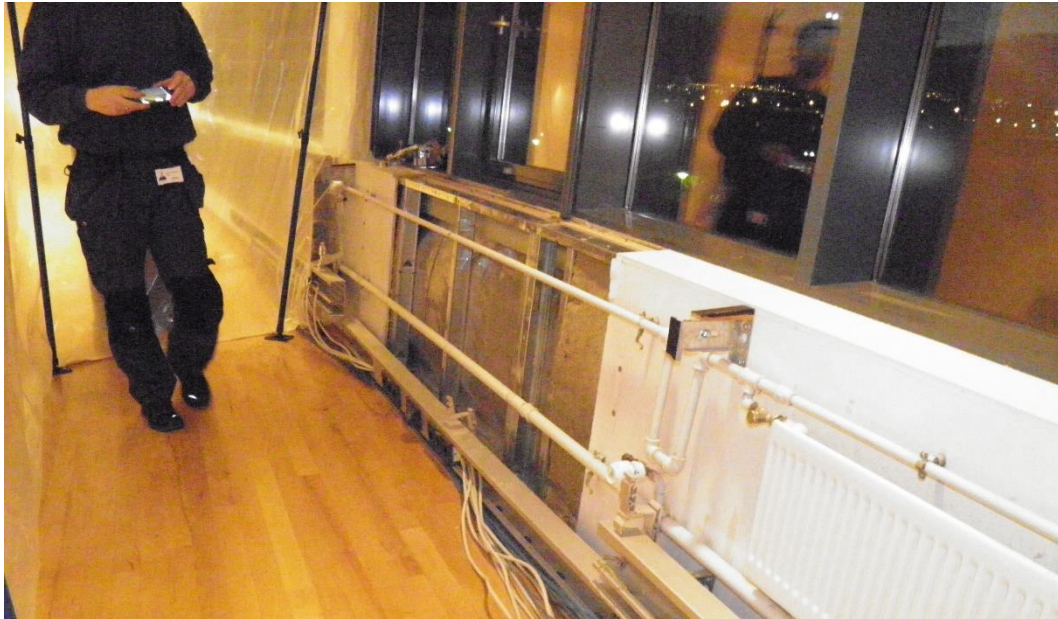
Mynd 3: Útveggur hússins sem er uppbyggður úr álguggakerfi og innri klæðningu.
