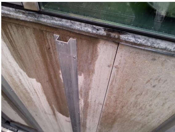
Mynd 17: Á norðurhluta austurhliðar er ekki vatns-heldur öndunardúkur líkt og á suðurhlutanum og ekki er búið að kitta í gluggaföls. Uppbygging kerfis-ins er að öðru leiti það sama.
