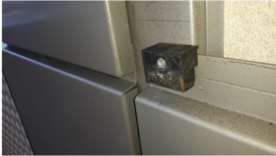
Mynd 35: Á mynd má sjá útlit og frágang plastfestingar í endaleiðara í áklæðningu. Festingarnar eru skrífaðar í leiðara með ryðfrýrri bodyskrúfu.
