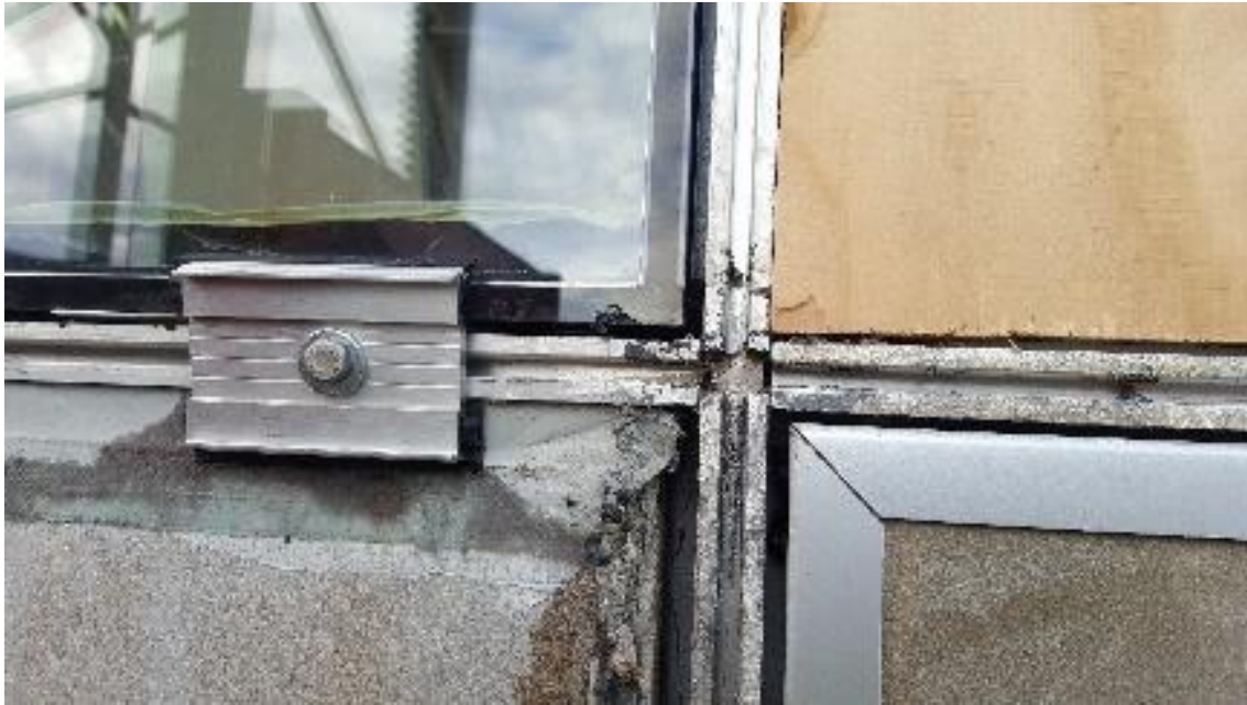
Mynd 6 Á mynd sem tekin er á rannsóknarsvæði á austurhlið hússins má sjá eldri frágang á Viroc sementsbundinni plötu til vinstri og endurbættum frágangi á Viroc plötu til hægri. Mikið kítti var í gluggafölsum sem þarf að fjarlægja svo drenrásir í gluggakerfi virki eðlilega.
