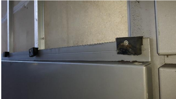
Mynd 27: Álkassettur eru festar með plastkubbum. Álplötum er svo smeygt undir plastkubbana að neðan en festar með skrúfum eða klemmdar fastar af ofan með þrýstiglerjunarlistum.
