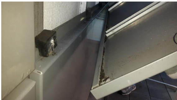
Mynd 37: Á mynd má sjá hvernig álplötur eða kassettur krækjast undir festingu. Ummerki eru um að plötur hafi verið beyglaðar við uppsetningu.
