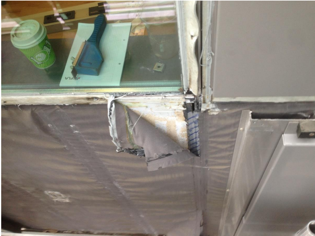
Mynd 13: Á austurhlið hússins er klætt yfir sementsbundnar trefjaplötur (VIROC) með vatnsheldum öndunardúk. Gluggafölsum er lokað að utan með þéttiborðum og þar yfir koma glerlistar sem halda plötum og gleri föstum í falsi gluggakerfisins. Álklæðing er fest utan á plötur í gluggakerfinu auk þess sem állistar pressar hana fasta. Búið er að kittu í gluggaföls utan með plötum. Frágangur er með þeim hætti að vatn kemst inn í gluggaföls en ekki er augljós drenun út úr gluggakerfinu nema undan gleri. Auk þess má sjá að drenrásir eru víða stíflaðar með kitti.
