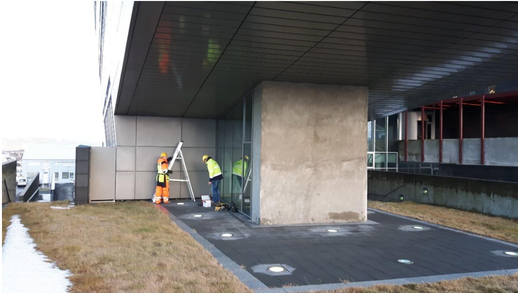
Mynd 25: Skoðunarstaður var undir útkrögun á suðurgafli hússins en ástæða fyrir þessum skoðunar stað var auðvelt aðgengi. Blicksmiður var fenginn til að aðstoða við skoðun.
