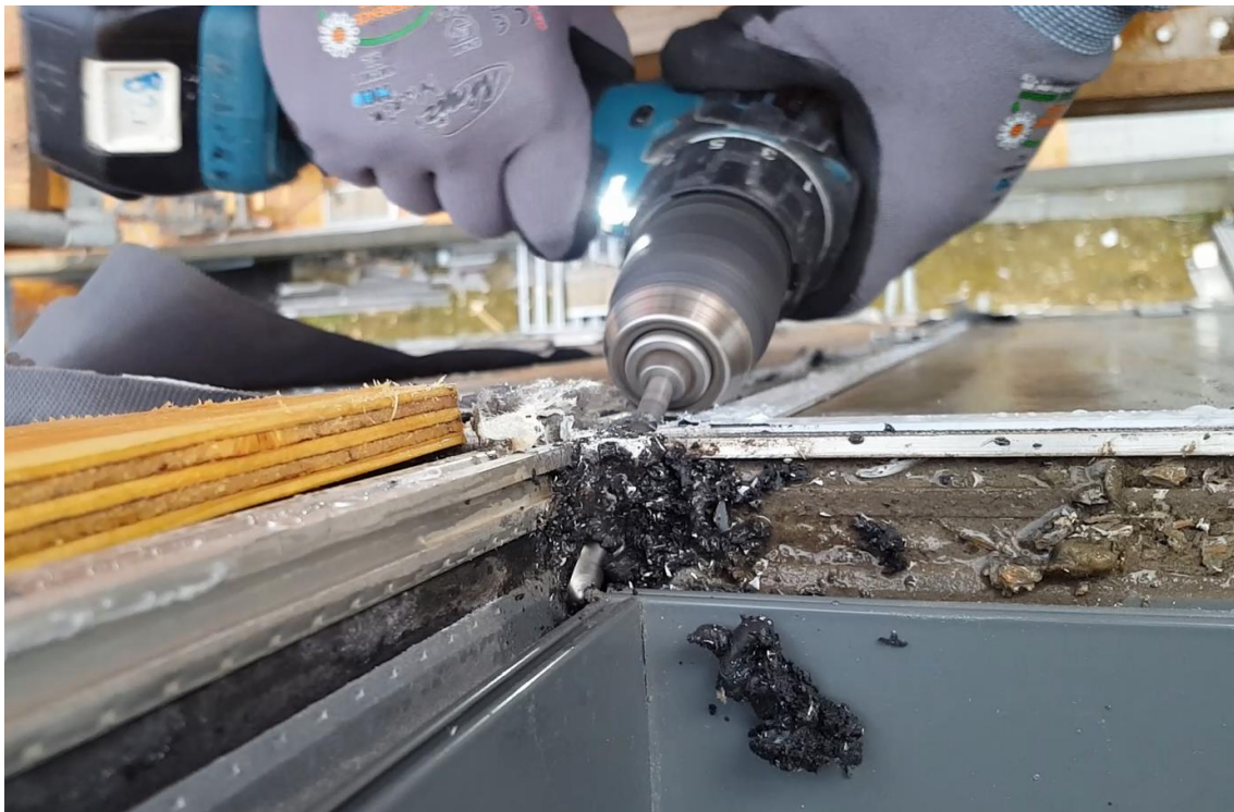
Mynd 7 Mynd sýnir hreinsun á kíttisþéttingu í gluggafalsi í drenrás prófílakerfis.
