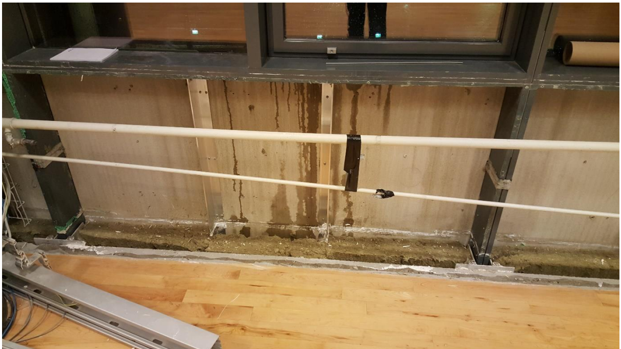
Mynd 10 Leki í útvegg eftir framkvæmd lekaprófunar
