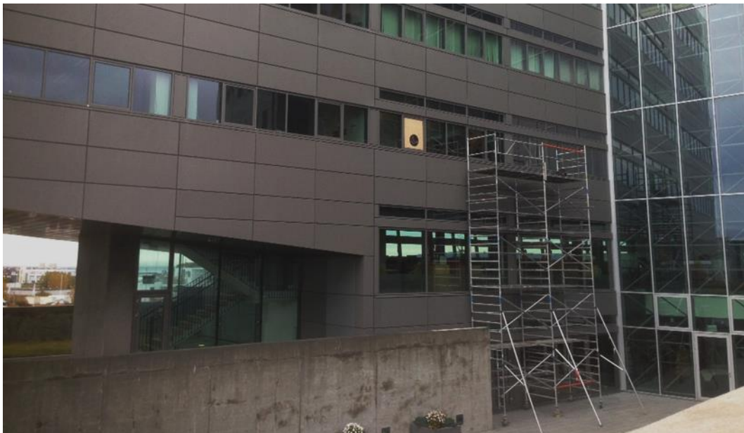
Mynd 2: Veðurhjúpur vesturbyggingar er uppbyggður úr álguggakerfi og áklæðningu. .
