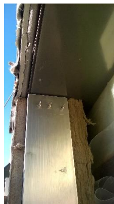
Mynd 26 Dæmi um Viðbótarprófíl sem situr framar en pakkning þannig að Viroc platan getur ekki lagst að pakkningu og pressan verður alltaf léleg og þ.a.l verður opið fyrir ofan.
