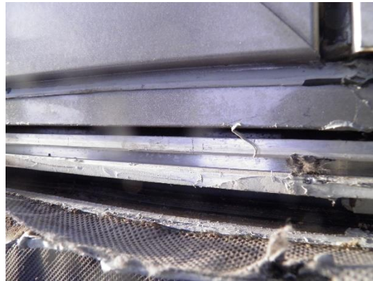
Mynd 22 Dæmi um of litla Viroc plötu þannig að vatn sem er í drenrásinni getur hæglega komist inn. Einnig er ólíklegt að svona tæpt sæti geti tryggt rétta pressu.
