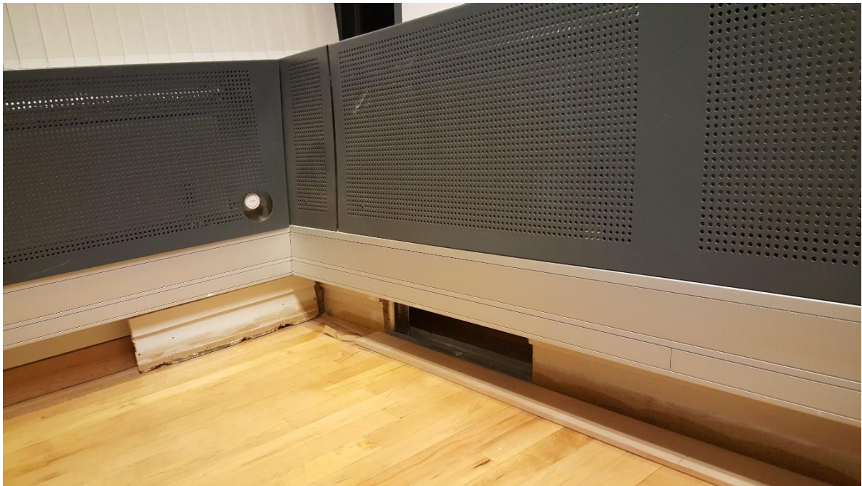
Mynd 13 Hér má sjá dæmi um rannsóknargat í útvegg.
