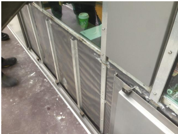
Mynd 9: Á mynd má sjá frágang klæðningar á austurhlið (suðurhluti). Á hæðarskilum á milli glugga eru álklæðning á álgrind (leiðarar) sem er fest á sementsbundnar (VIROC) plötur í gluggakerfinu.
