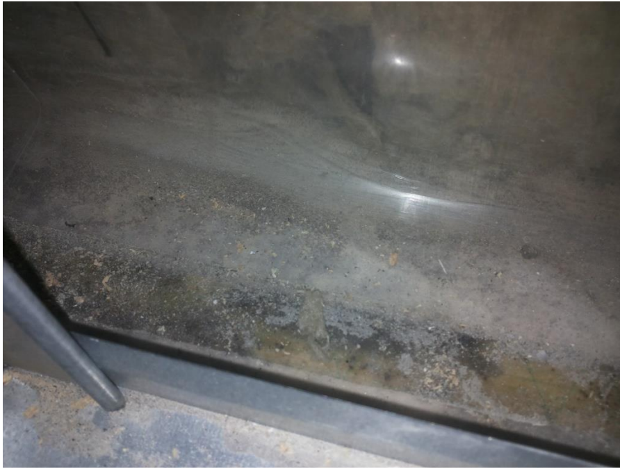
Mynd 11 Á mynd má sjá myglu á bak við rakavörn í gipsi í norðurenda 6.hæð
