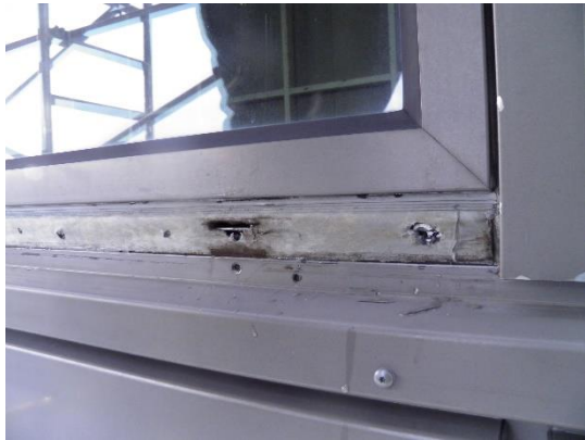
Mynd 21 Dæmi um opin péttibönd sem halda frekar vatni að í stað þess að tryggja þéttingu.
