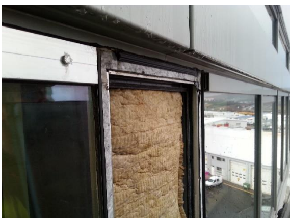
Mynd 19: Á milli glugga eru lokuð bil með álplötum að utan, einangrun í gluggabili og spónaplötum að innan. Töluverð bleyta var í gluggabili og er líklegt að frágangur þéttista í gluggafalsi sé ekki nægjanlega góður.
