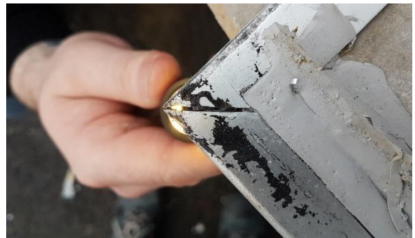
Mynd 10 Samskeyti U-skúffu eru óþétt og hér má sjá ljós koma í gegnum samskeyti á horni. Þetta leiðir til loftleka í hornum Viroc plötu.
