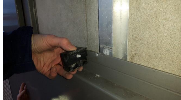
Mynd 28: Festingar (plastkubbar) voru nokkuð vel festar í miðjuleiðara og festipól almennt yfir viðmiðunargildum fyrir hönnunarálág festinganna.
