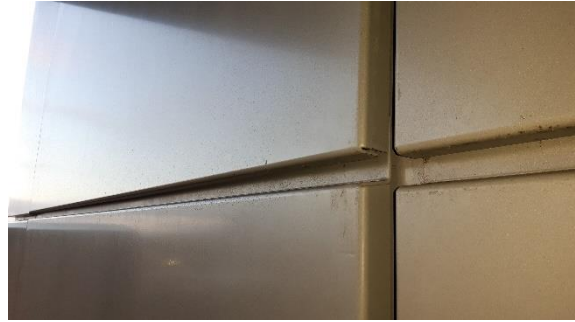
Mynd 36: Á mynd má sjá dæmigerðan stað þar sem endafestingar eru lausar. Líklegt er að þenslur í áklæðningu valdi losi og skemmi festingar.
