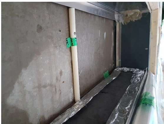
Mynd 27 Rakaibæting í kerfi með álbökkum sem vatn var sett í
