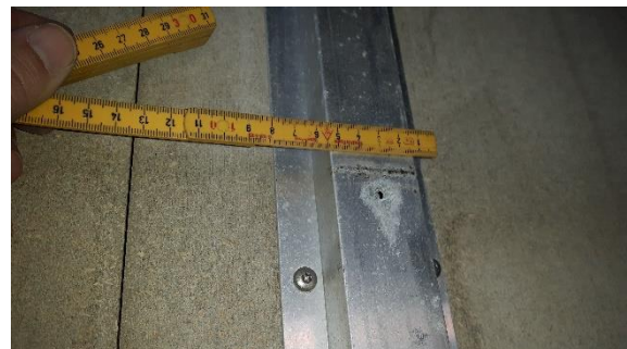
Mynd 30: Festingar á miðjuleiðurum voru almennt fastar. Skrúfur ná hins vegar lítið inn í álleiðara og ekkert umfram það sem mauðsynlegt er.
