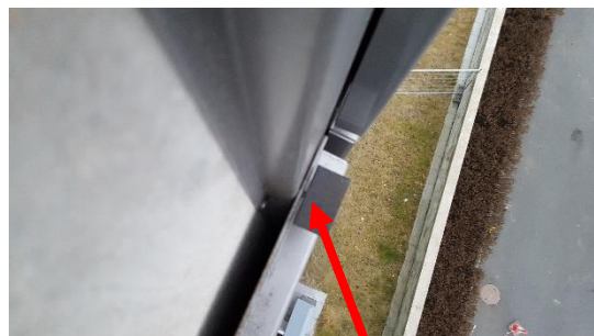
Mynd 32 Dæmi um los á festikubb í 2,0mm þykku efni. Ekki hafa fundist dæmi um sambærileg mál í 3,0mm milliprófílum.
