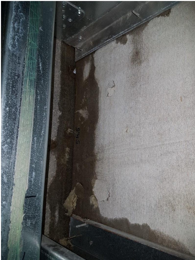
Mynd 11 Á mynd má sjá myglu á bak við rakavörn í gipsi í norðurenda 6.hæð
