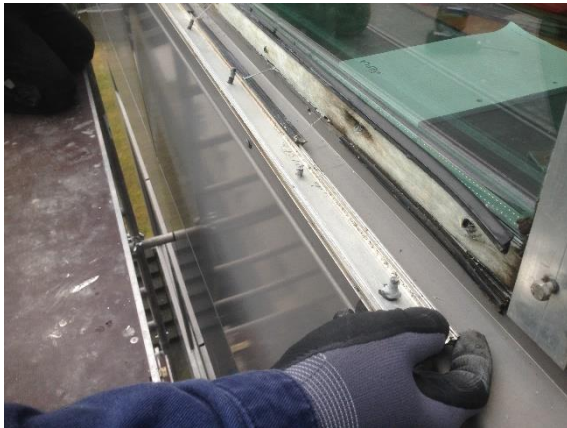
Mynd 7: Glerlistar (prýstilar) teknir af gleri og áfellum utan með gluggum. Undir glerlistum eru þéttiborðar sem loka gluggafalsi að utanverðu. Göt eru í þéttiborðum eftir skrúfur í glerlistum.
