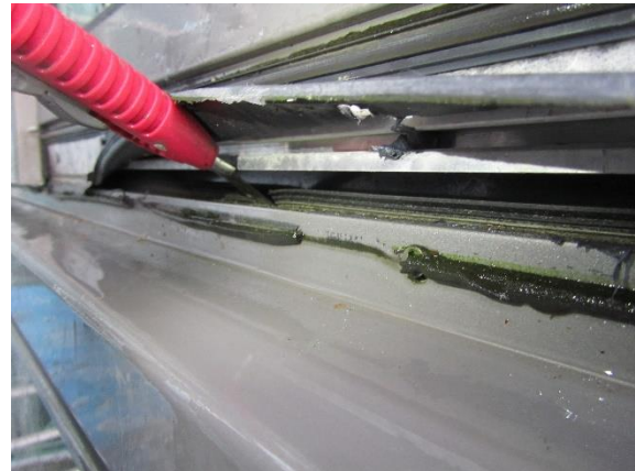
Mynd 16: Við skoðun inn í föls á gluggakefi kom í ljós að VIROC-plötur er það stuttar að þær ná varla upp á þéttista í gluggafalsi og sumstaðar ekki. Hægt er að stinga hníf á auðveldan hátt milli lista og plötu.
