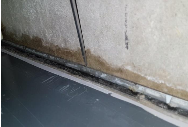
Mynd 25 Rakaibæting í kerfi, leki með skúffum
