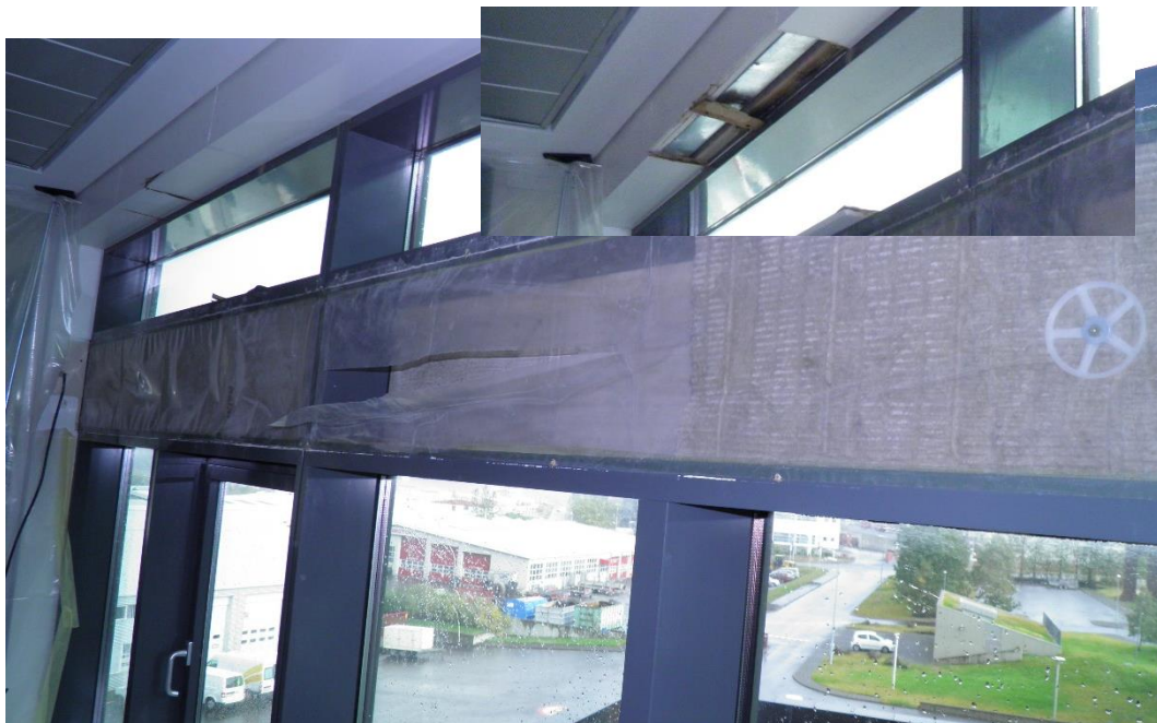
Mynd 22: Sjá má ummerki um leka innanhúss á móts við skoðunarstað utanhúss á 3. hæð. Klæðning í lofti sem gengur út að gluggum er rakaskemmd og mygla í trégrind þar fyrir innan. Rekja má leka til frágangs á VIROC plötum (stuttar) og einnig eru gúmmíþéttingar í gluggafölsum þunnar og dekkja mögulega ekki hrjúfleika platnanna. Rakasperra innan á gluggakerfi var nokkuð vel frá gengin en þó mátti sjá loftlekaleiðir á milli gluggaeininga. Ekki er heldur hægt að ætla að VIROC plötur séu loftþéttar vegna opinna skrúfugata, skemmda og rífa í plötum og það getur valdið rakapéttingu inni í gluggakerfinu.
