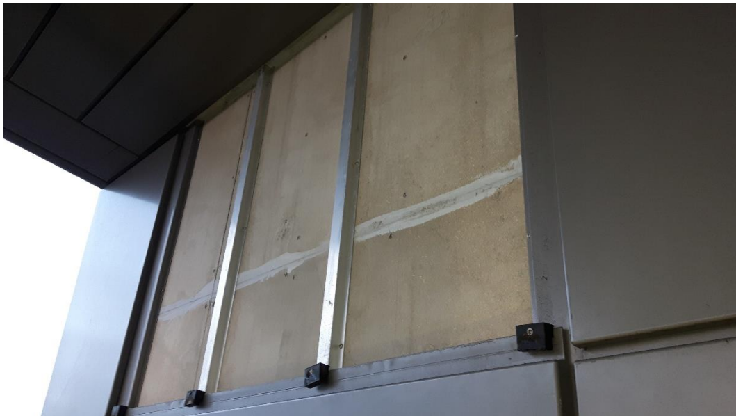
Mynd 26: Álplötur voru teknar af útvegg hússins undir suðurgafli. Frágangur áklæðningar á þessum stað er með sama hætti á á öðrum hliðum hússins nema að því leiti að ekki eru gluggar á þessum stað og einungis eru tveir miðjuleiðarar í stað þriggja á gluggahliðum hússins. Búið var að skrúfa plötur fastar að ofan með utanálíggjandi skrúfum líkt og búið er að gera undir gluggum á gluggahliðum.
