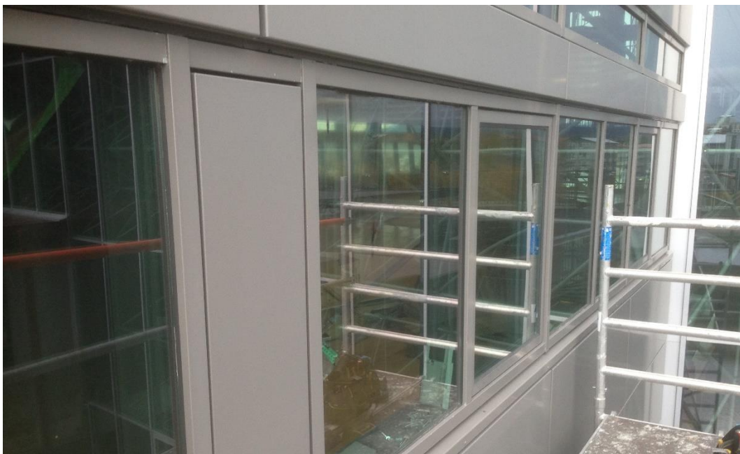
Mynd 4: Að utanverðu eru hefðbundnir álguggar og gluggakerfi með áklæðningu á milli glugga.
