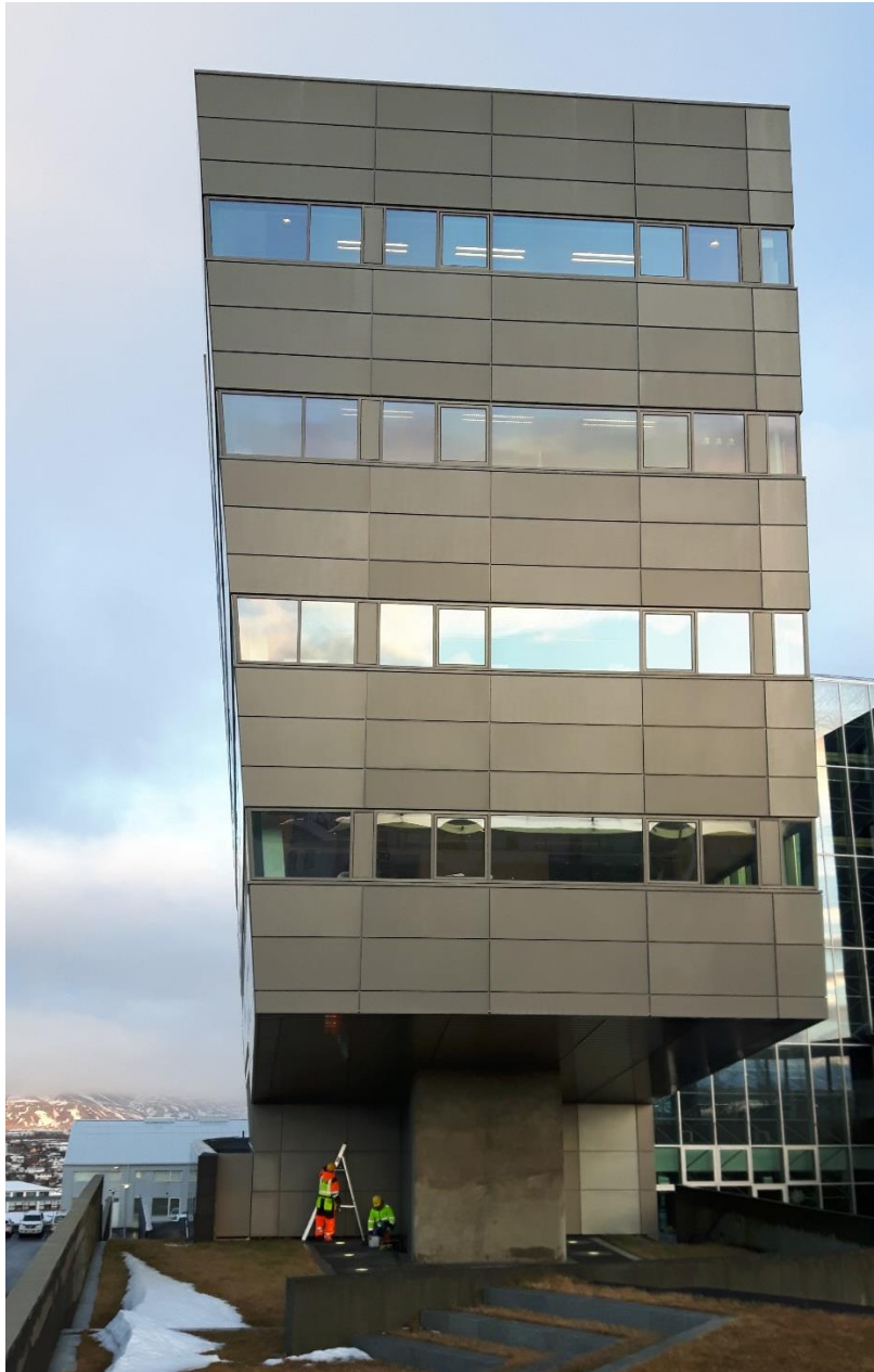
Mynd 23: Á mynd má sjá suðurgafli hússins (Vesturhús). Hjúpflötur hússins er uppbyggður úr Curtein wall gluggakerfi þar sem álkassettur eru hengdar utan á gluggakerfið með földum festingum, festar með því að klemmar þær fastar í gluggakerfið undir glerlista (þrýstillista).
