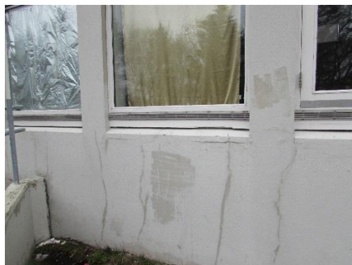
Mynd 2.16 Sprungur undir gluggum
