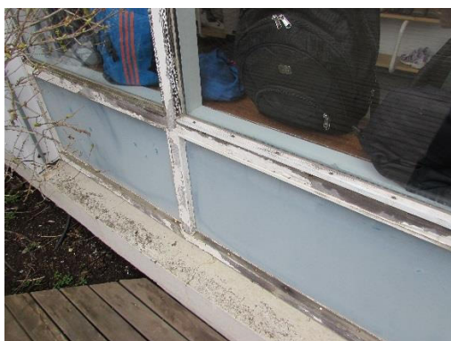
Mynd 2.23 Myndir 2.23 -2.25 sýna ónýta glerlista og illa farna glugga
