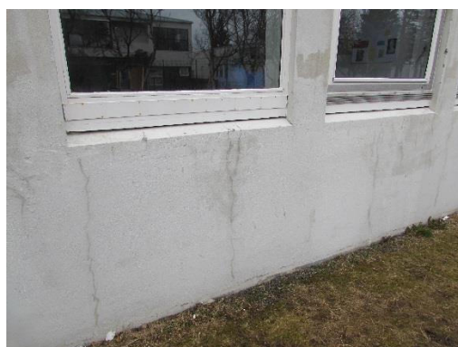
Mynd 2.18 Sprungur undir gluggum
