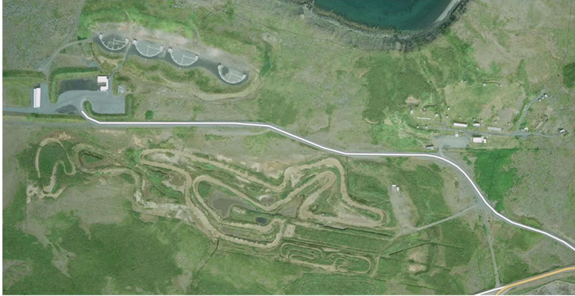
Skotæfingasvæði norðan vegarins og vélhjólasvæði sunnan við.
