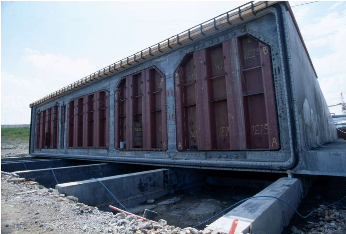
Mynd 23: Tilbúin eining með stálpiljum og gúmmípétti.
