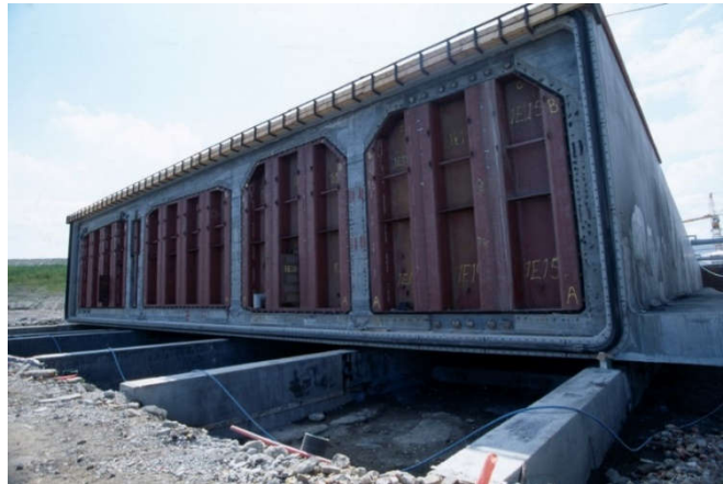
Mynd 8: Tilbúin eining með stálþiljum og gúmmíþétti.
