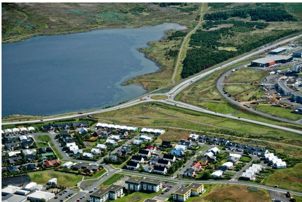
MYND 2.2 Sunnanvert Rauðavatn. Byggðin þrengir að vegstæðinu.
