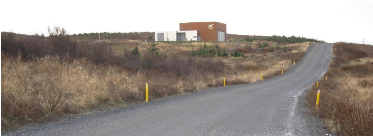
MYND 2.22 Vegbrekkur og aðveitustöð Veitna.
