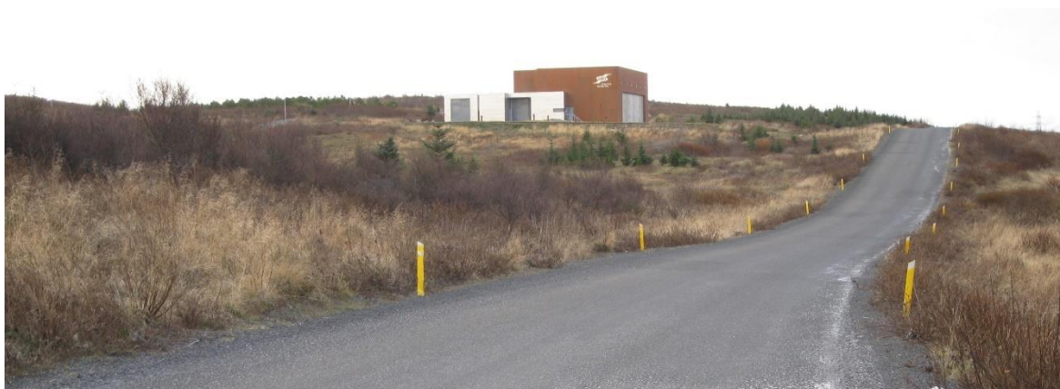
MYND 2.22 Vegbrekkur og aðveitustöð OR.
