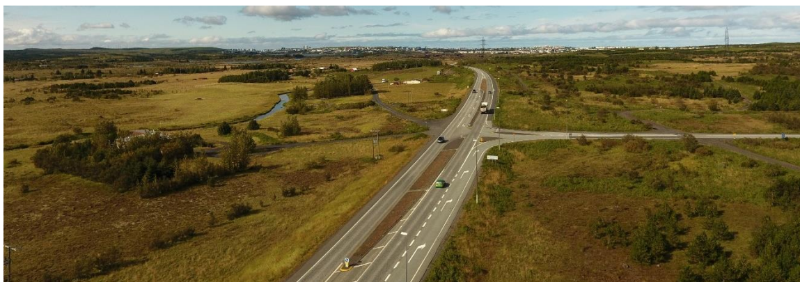
MYND 24 Vegamót við Hafravatnsveg. Íbúðarhúsið að Helli til vinstri í trjálundinum.
