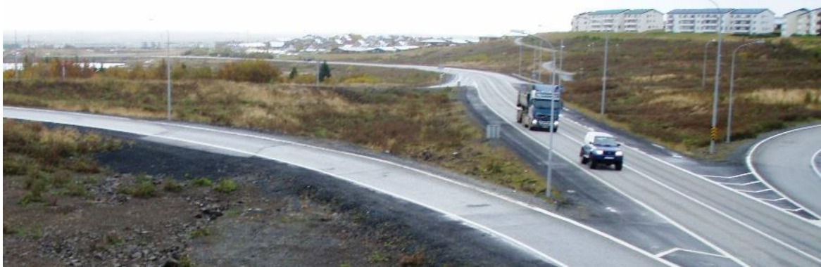
MYND 3.4 Vegamót við Bæjarháls, horft af brú til suðurs. Aðlaga þarf að- og fráreinar.
