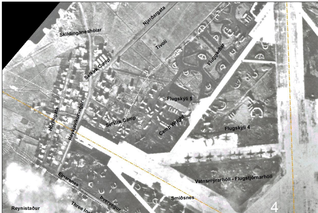
Mynd 49. Svæði 4 árið 1942. Þá standa enn 20 skeifulaga flugvélabyrgi, Flugskýli 4 er ekki risið, en sjá má herbúðirnar Selkirk Camp norðan við flugbrautina og Camp Wright við Flugskýli 5. Ekki er búið að byggja flugbrautina yfir Reykjavíkurveg. 137
