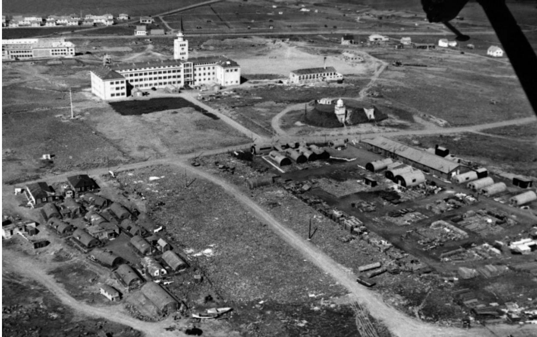
Mynd 15. Braggahverfi breska hernámliðsins á Rauðarárholti um 1946, Camp Sheerwood til vinstri og Camp Tower Hill til hægri, sunnan við Háteigsveg. Langa húsíð sunnan við vatnsgeymana er fiskverkunarhús Ara fróða hf. og síðar Kveldúlf. 66
