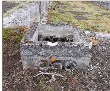
Mynd 46. Steypur kassi við norðurgafl (214-102), horft til suðurs.
