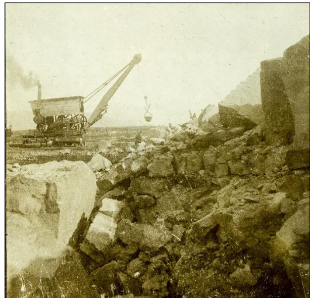
Mynd 10. Hér má sjá gufukrana lyfta upp grjóti í Öskjuhlíðinni um 1913. 32
