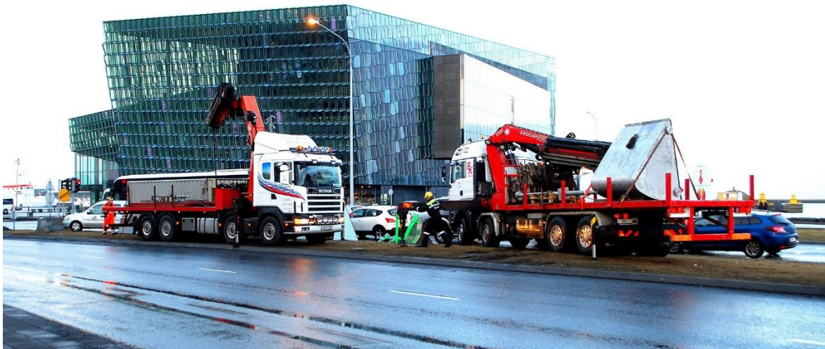
Mynd sýnir vinnu við endurnýjun á neyðarloku fyrir dælustöðina við Skúlagötu árið 2015. Sjá má neyðarlökuna á vörubílsfallinum hægra megin á myndinni.
