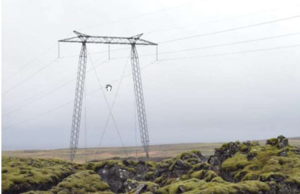
Mynd 6.1 Mastur í Búrfellslínu 3b, stagað stálgindarmastur.
