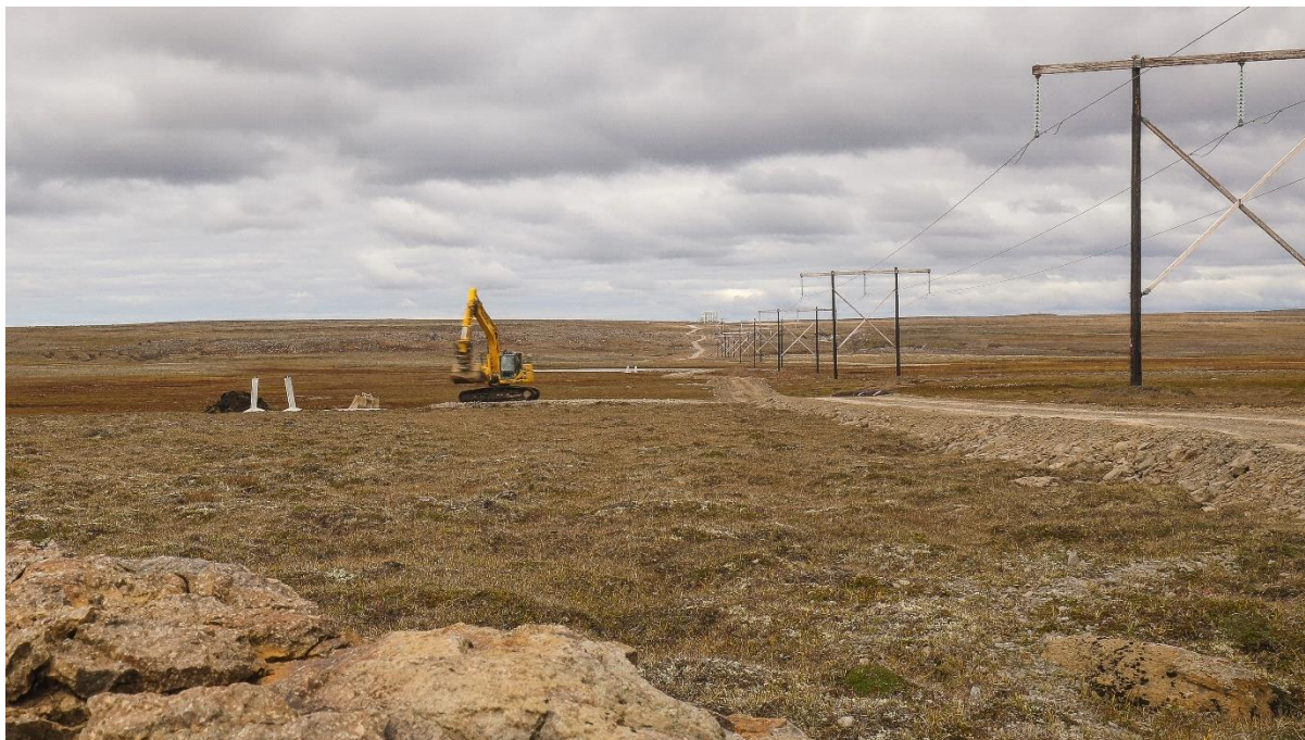
Mynd 6.10. Slóðagerð við Kröflulínu 3. Á myndinni sést núverandi 132 kV loftlína þar sem lögð hefur verið slóð samsíða og undirbúin mastraplön fyrir nýja 220 kV Kröflulínu 3.
