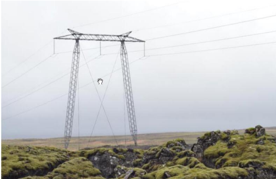
Mynd 6.1 Mastur í Búrfellslínu 3b, stagað stálgindarmastur.
