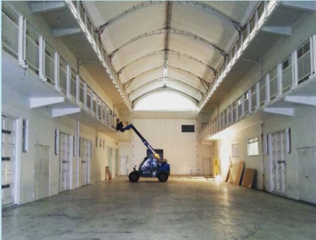
Listaverkageymslur – tækni- og bakrými
