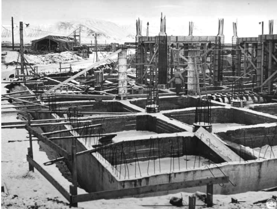
Fiskidjuverið í byggingu. Í baksýn sést að bygging fyrstu verbúðanna er einnig hafin. 45
