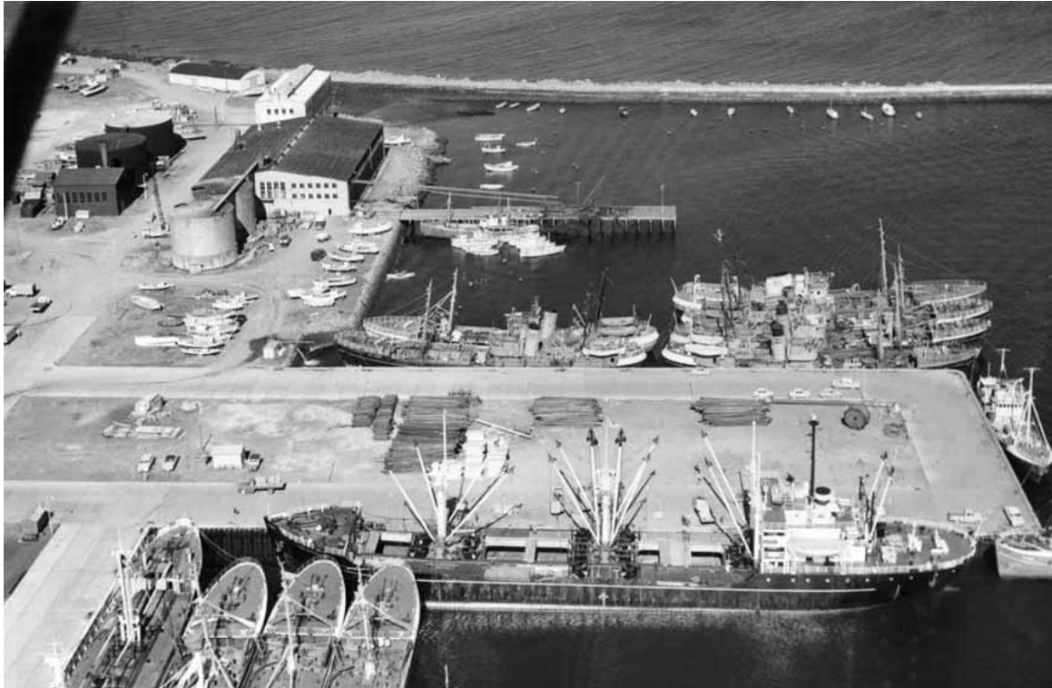
Grandabryggja, togarabryggjan sem gerð var austur úr Grandagarðinum á 6. áratugnum. Norðar má sjá Olúbryggjuna við Faxaverksmiðjuna og Norðurgarðinn, sem ekki var enn farið að breikka á þessum tíma. 76
