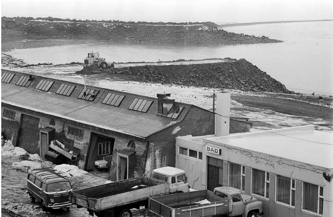
Mynd tekin árið 1981 þegar byrjað var á uppfyllingu vestan verbúðanna, sem áður höfðu þjónað sem varnargarður gegn norðvestanbriminu. Til hægri sést baðhúsið að Grandagarði 101. 126
