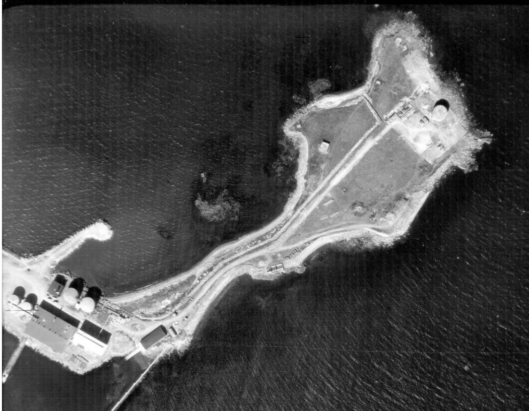
Örfirisey og norðurendi Grandagarðs úr lofti árið 1951. Sjá má byggingar Faxaverksmiðjunnar í neðra vinstra horni. Á norðurenda Örfiriseyjar er byrjað að reisa fyrstu mannvirki olústöðvarinnar. 54
