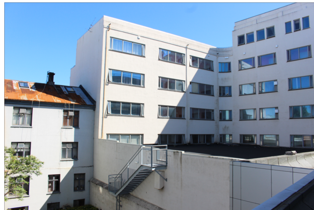
LJÓSMYNDIR AF NÚVERANDI YFIRBRAGÐI Á BAKHLIÐ BYGGINGARINNAR
