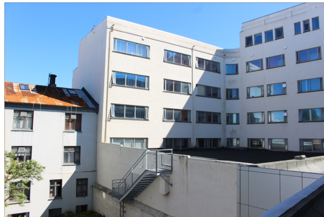
LJÓSMYNDIR AF NÚVERANDI YFIRBRAGÐI Á BAKHLIÐ BYGGINGARINNAR
