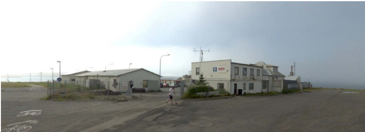
Mynd 80 Húsin eins og þau litu út í júlí 2017, horft til suðurs. 250
