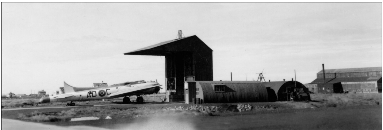
Mynd 62 Viðgerðarskýli, eða nefskýli, var reist til viðgerðar á flugbátum árið 1942. Til viðgerðar er Boeing B-17 Mk II vél sem var notuð til veðurathugana og tilheyrði 251. flugsveit breska flughersins. Tveir braggar í forgrunni. Í bakgrunni er flugskýli sem kallað var Gróðurhúsið. 188
