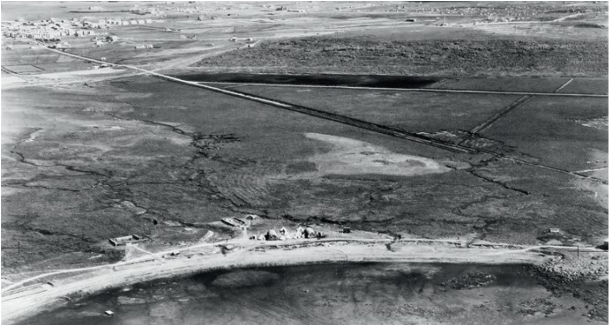
Mynd 31 Flugvallarsvæðið í Vatnsmýri og Seljamýri, séð úr lofti frá Skerjafirði, 19. júlí 1940. Öskjuhlíð er efst fyrir miðju á myndinni. Vegirnir sem sjást eru núverandi Nauthólsvegur (fjær) og vegur sem unnið var við á þessum tíma (nær) og varð síðar akstursbraut með N/S-flugbrautinni. Við ströndina í Shellvík var athafnasvæði Walrus flugbátasveitarinnar. Myndin er tekin rúmlega þremur mánuðum áður en Bretar hófu flugvallargerð. 120
