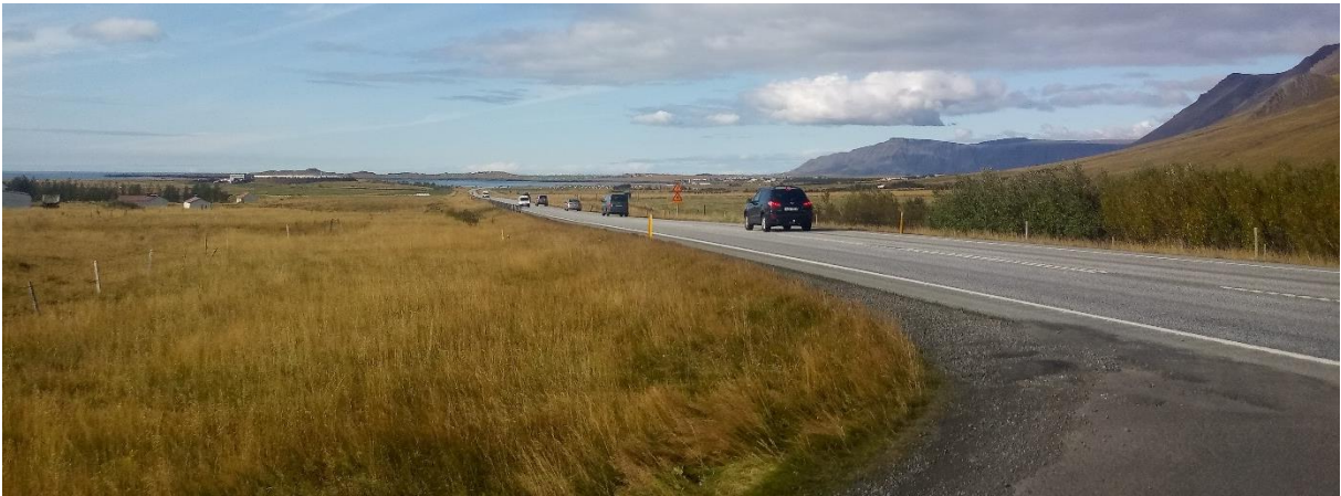
MYND 5.4 Séð til norðvesturs yfir núverandi Vesturlandsveg frá afleggjara að Enni.
