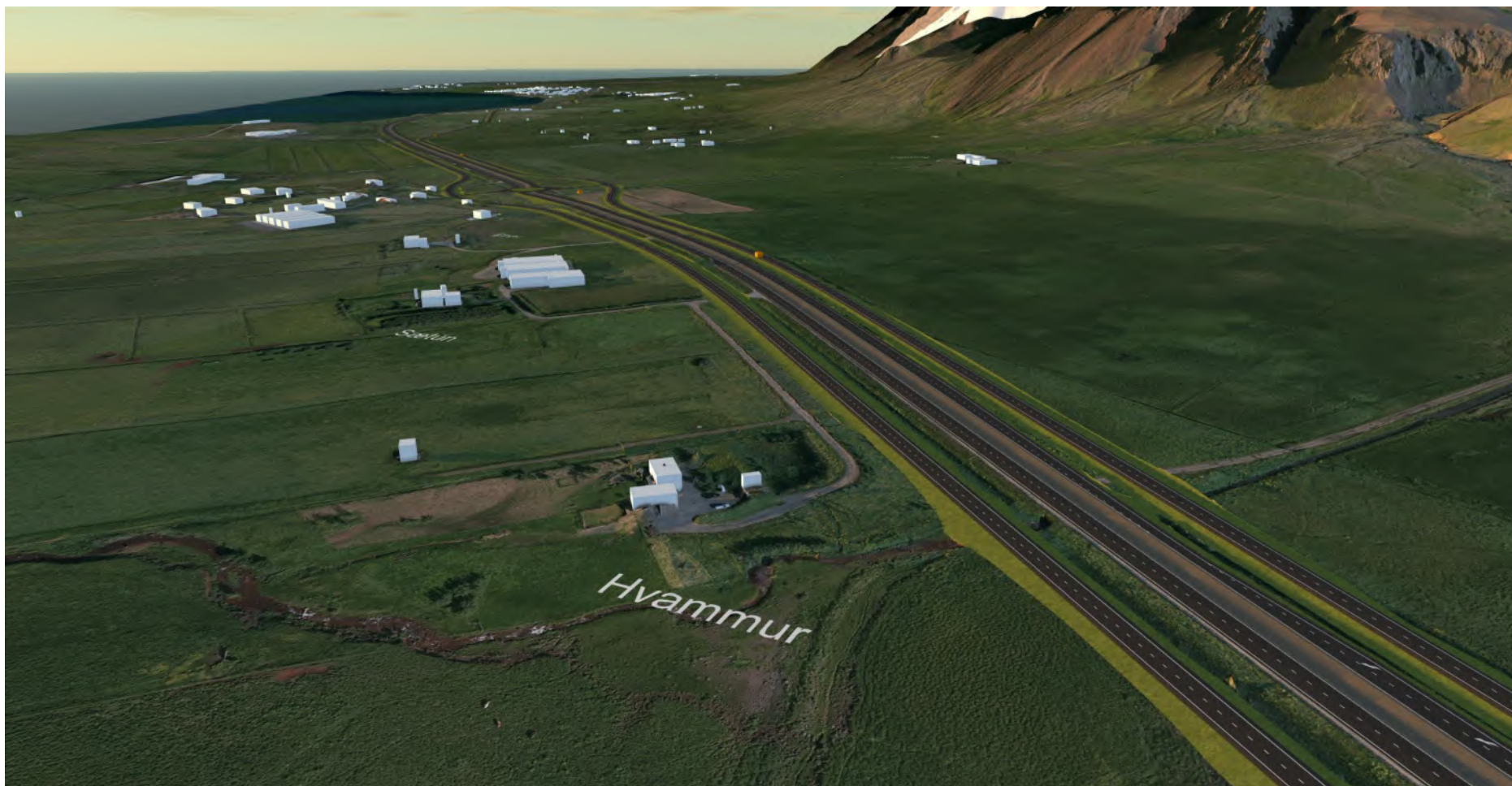
MYND 10b Horft til norðurs eftir Vesturlandsvegi. Sjónarhorn staðsett um 150 m yfir landi við bæinn Hvamm. Grundarhverfi sést nyrst á myndinni. Eftir framkvæmdir. Mynd: Verkís.
