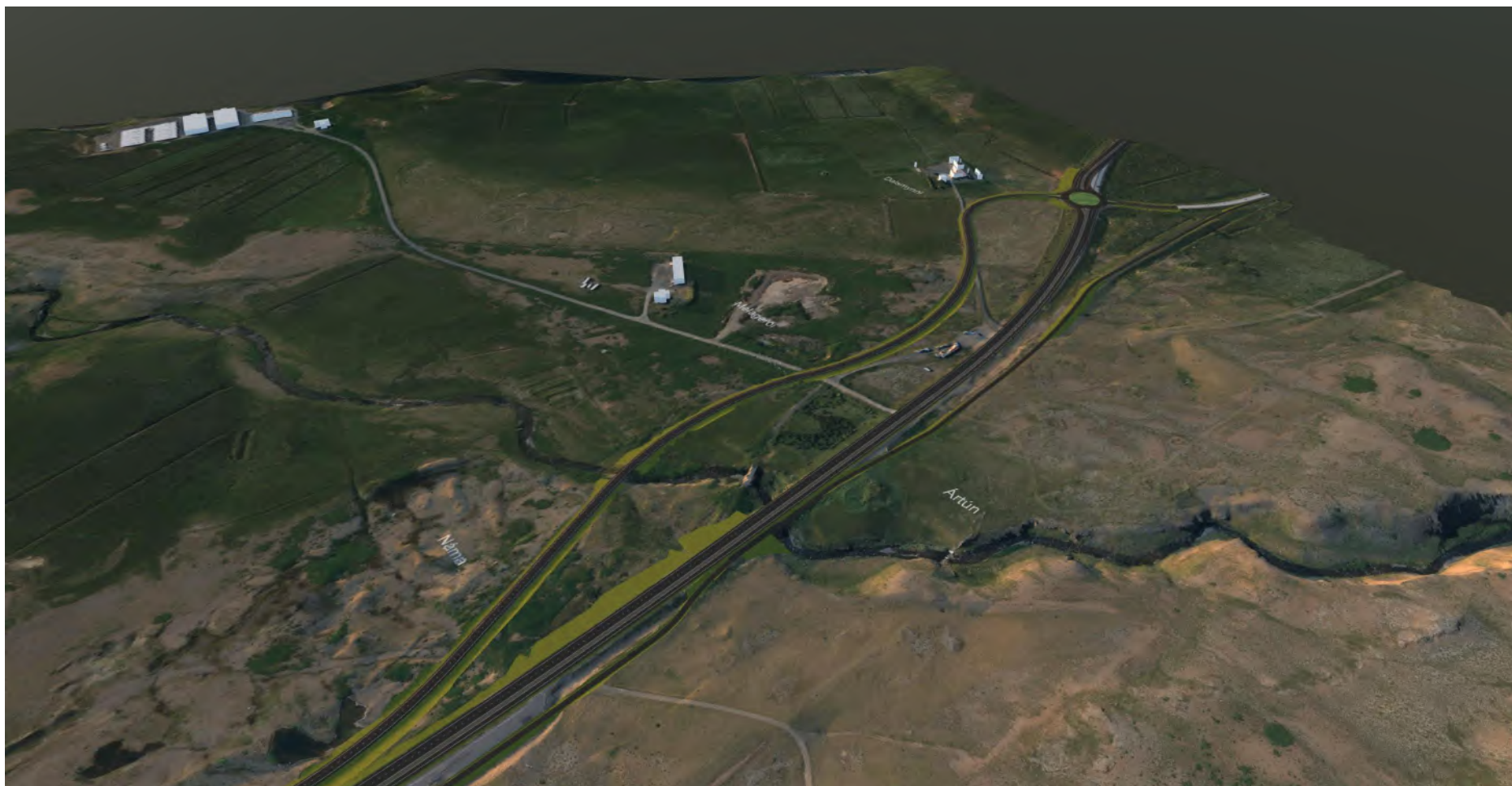
MYND 16b Horft til norðvesturs eftir Vesturlandsvegi. Sjónarhorn staðsett um 300 m yfir landi suðaustan Blikdalsár. Á myndinni sést Vesturlandsvegur, ásamt nýjum hliðarvegi vestan Vesturlandsvegar og nýju hringtorgi við Hvalfjarðarveg. Eftir framkvæmdir. Mynd: Verkís.
