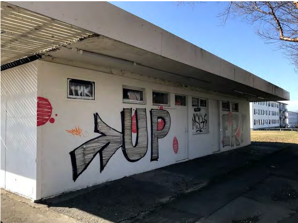
Mynd 12. Austurhlið Arnarbakka 2. Hér var áætlað að hafa almenningsasalerni, en sennilega voru þau aldrei starfrækt. 40
