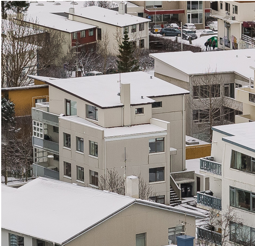
MYND 17 Smáíbúð innréttuð í þakrymi.
