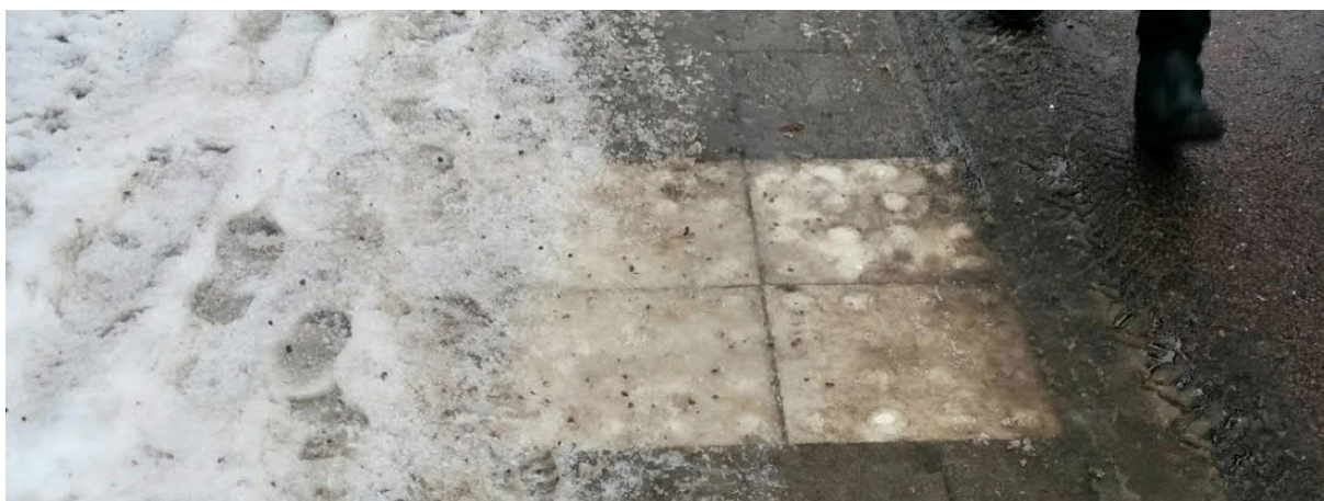
Mynd 4-15 Huga verður að snjóhirðu og að snjór þeki ekki yfirborðsmerkingar (Mynd: Berglind Hallgrímsdóttir).
