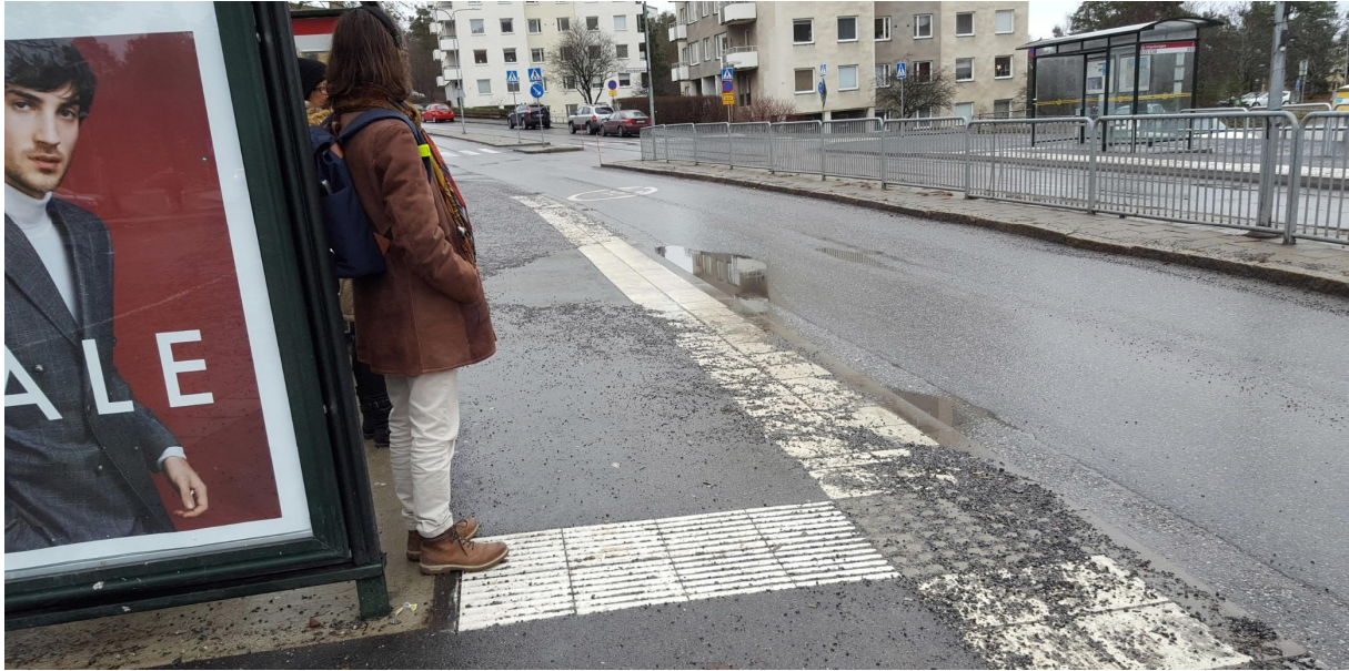
Mynd 5-4 Stoppistöð með biðskýli, leiðarlínur frá biðskýli að uppstigi og breiðri hellurönd í öðrum lit en nærliggjandi umhverfi við jaðar stoppistöðvarpall. Stoppistöðvarpallur og biðsvæði er sami flöturinn á þessari biðstöð (Mynd: Stefán Vilbergsson).
