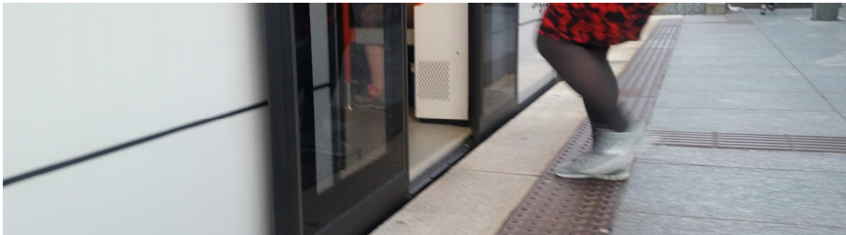
Mynd 5-2 Þægilegt aðgengi frá stoppistöðvarpalli rakleitt inn í vagninn, búið er að hækka kantstein hér (Mynd: Áslaug Katrín Aðalsteinsdóttir).
