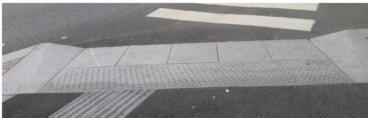
Mynd 4-21 Myndin sýnir útfærslu sem er villandi. Áhersluflötur liggur ekki þvert á göngustefnu og því er sá sem er blindur eða sjónskertur leiddur skáhallt yfir götuna. Það tekur lengri tíma og getur leitt einstaklinginn í ógöngur (Mynd: Áslaug Katrín Aðalsteinsdóttir).
