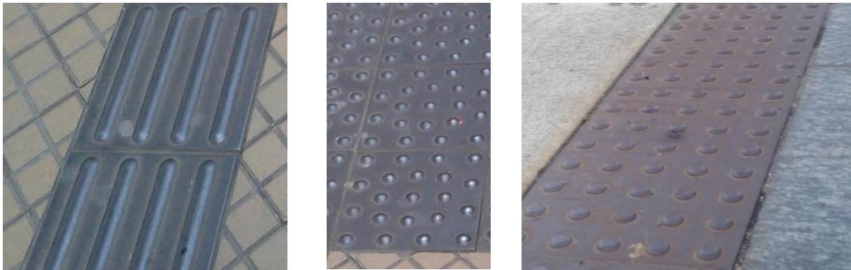
Mynd 4-12 Leiðarlínur; stefnueiningar (til vinstri) og áherslu- og varúðareiningar (í miðju og til hægri) Algengt er að einingarnar séu úr steypu, graníti eða steypujárni. Einnig eru til hnappar og línur úr öðrum málmi og fleiri efnum og eru þær festar við yfirborðsefni bæði innan- og utanhúss (Myndir: Áslaug Katrín Aðalsteinsdóttir).
