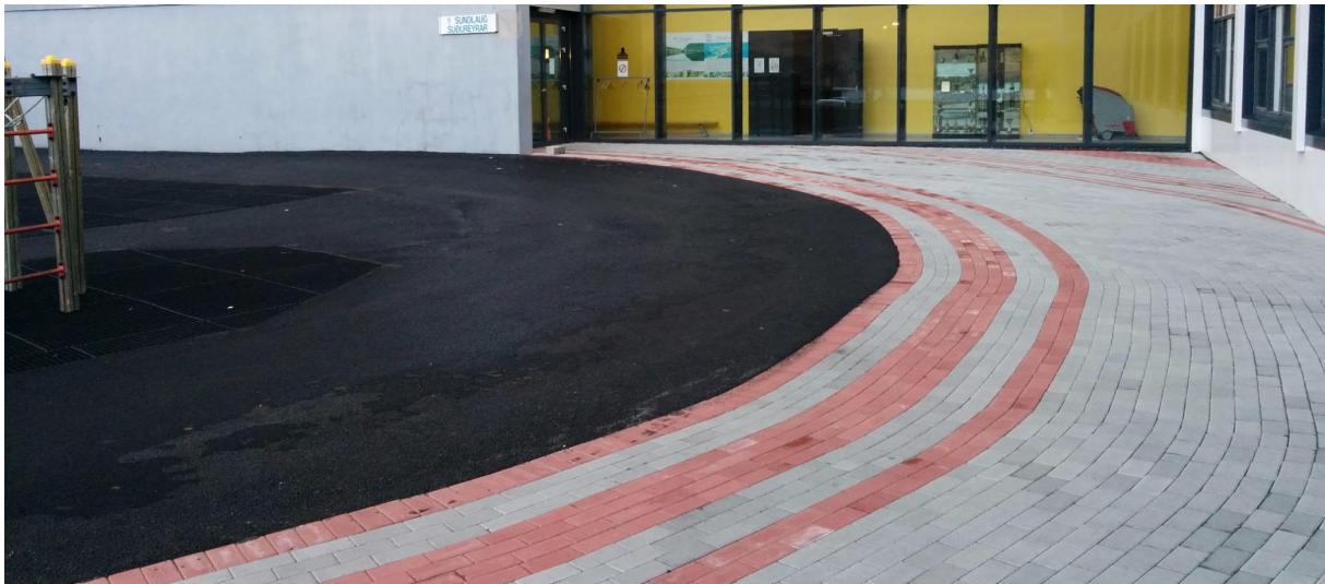
Mynd 4-32 Myndin sýnir inngang og útileiksvæði við grunnskólann á Suðureyri. Mismunur á yfirborði og lit greina á milli leiksvæðis í samrými og aðkomu að byggingu. (Mynd: Berglind Hallgrímsdóttir).
