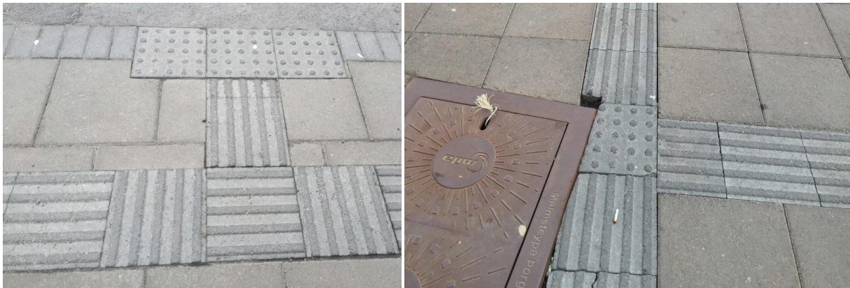
Mynd 4-25 Myndirnar sýna leiðarlínur við þveranir. Á mynd til vinstri er bent á stefnubreytingu með því að snúa stefnufleti þvert á göngustefnu. Blindir og sjónskertir eiga erfitt með að gera sér grein fyrir stefnubreytingunni við slíka útfærslu og kjósa frekar að hafa áherslu- og varúðarsvæði. Varúðarsvæði við þverunina er lítið (30cm djúpt) sem getur gert að verkum að fólk nær ekki að gera sér grein fyrir gatna- og stígamótum nógu tímanlega og gengur því út á götu. Á mynd til hægri er varúðarsvæði minnkað vegna brunns. Hér er varúðarflötur ekki nægilega stór til að blindir og sjónskertir geri sér grein fyrir gatna- og stígamótum. Frágangur eins og sést við horn á brunni getur einnig orsakað fallhættu (Myndir: Rannveig Traustadóttir).
