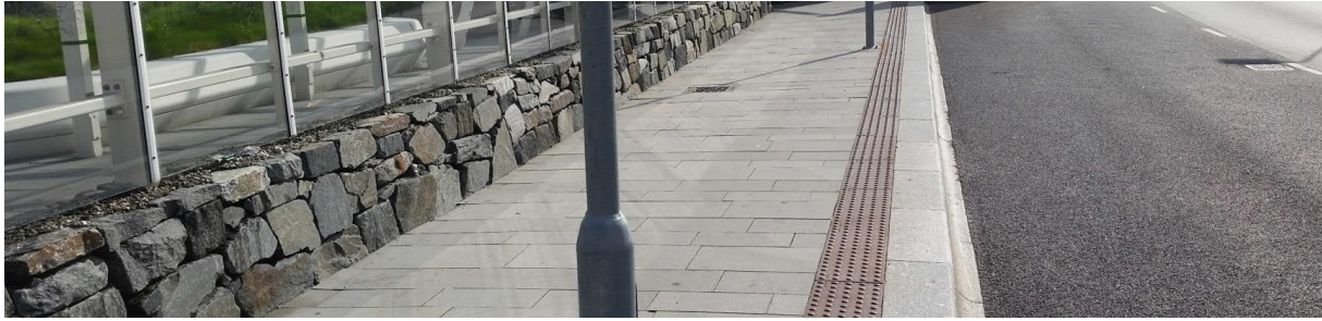
Mynd 4-11 Myndin sýnir hvernig ljósastaurar eru staðsettir of nálægt áherslusvæði, sem skapar hættu á að rekast á staurana (Mynd: Áslaug Katrín Aðalsteinsdóttir).
