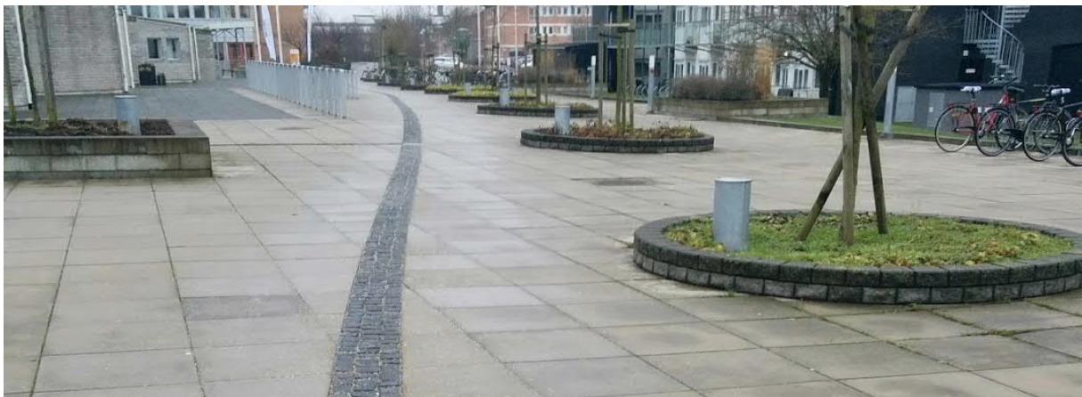
Mynd 4-10 Leiðarlínur í stóru opnu rými geta hjálpað blindum og sjónskertum að rata um og komast að og frá svæðinu. Gæta skal þess við efnisval leiðarlína að það skapi ekki hindranir (Mynd: Berglind Hallgrímsdóttir).
