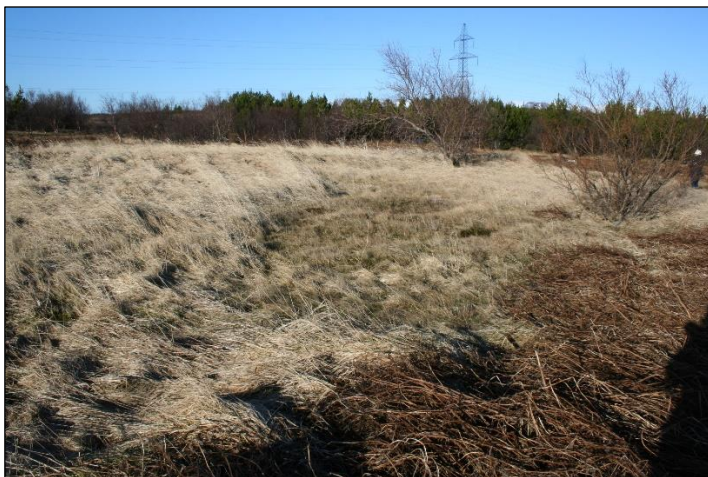
Mynd 36. Sólvellir, steypur grunnur (1953-14), horft í norður.
