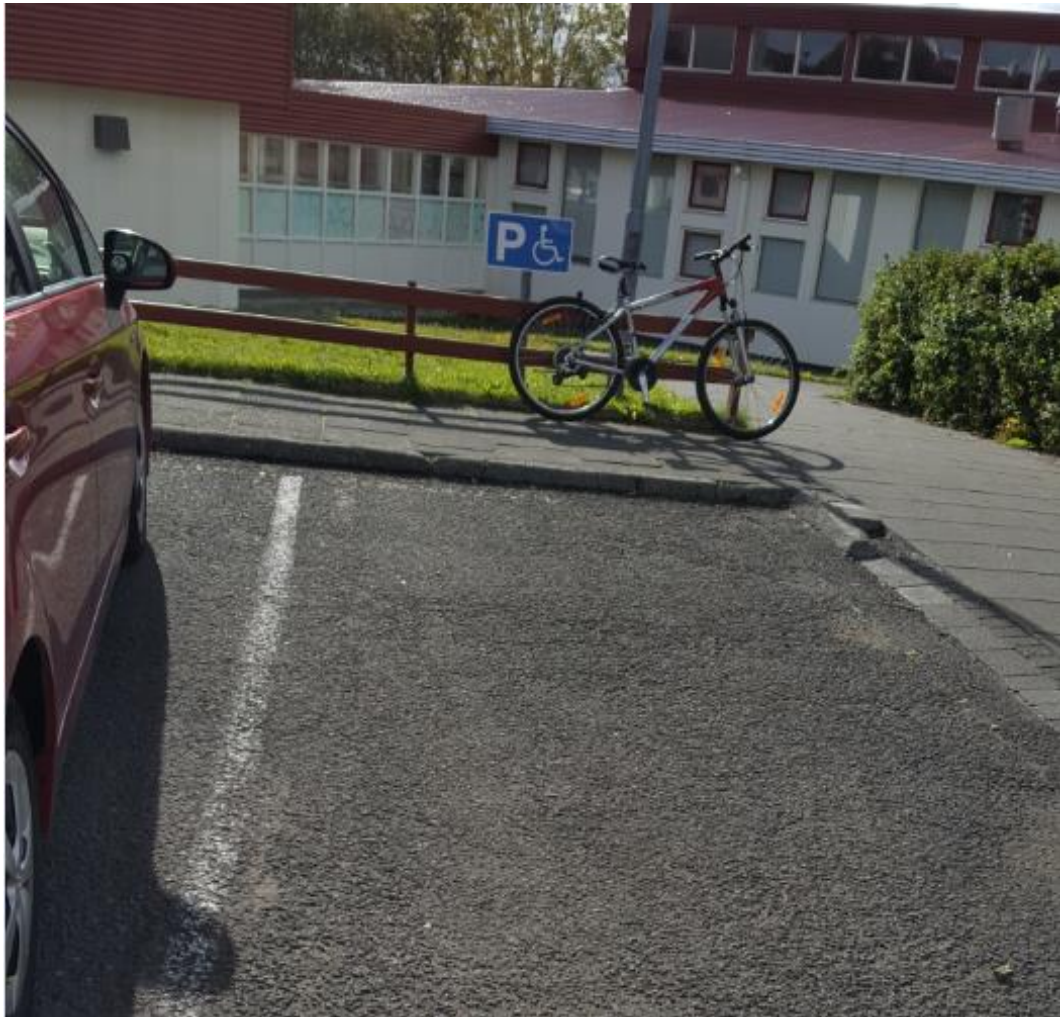
Mynd 2.14: Bílastæði fyrir hreyfihamlaða ekki nægilega breitt og ómerkt í yfirborði
