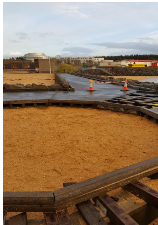
Mynd 2.16: Viðgerð stendur yfir á trégólfi útsýnispalls
