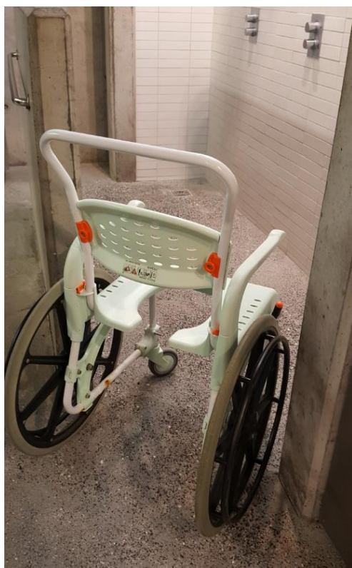
Mynd 3.8: Skilrúmsveggir í sturturýmum - Þröngt bil 73-77 cm.
