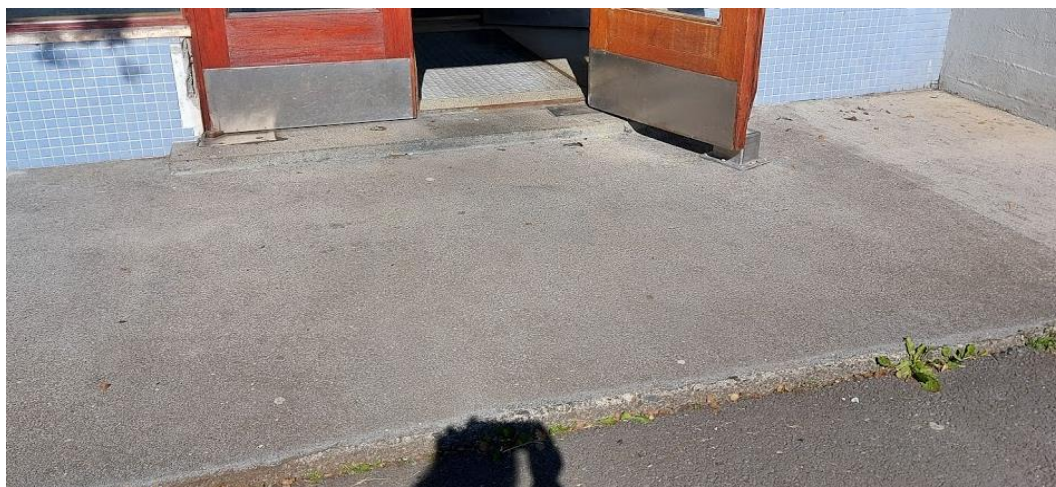
Mynd 1.5 Þrep við aðkomu við inngang sunnan megin, austan til.
