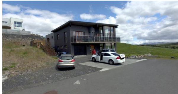
Horft yfir lóðina Gerðarbrunn 44.
