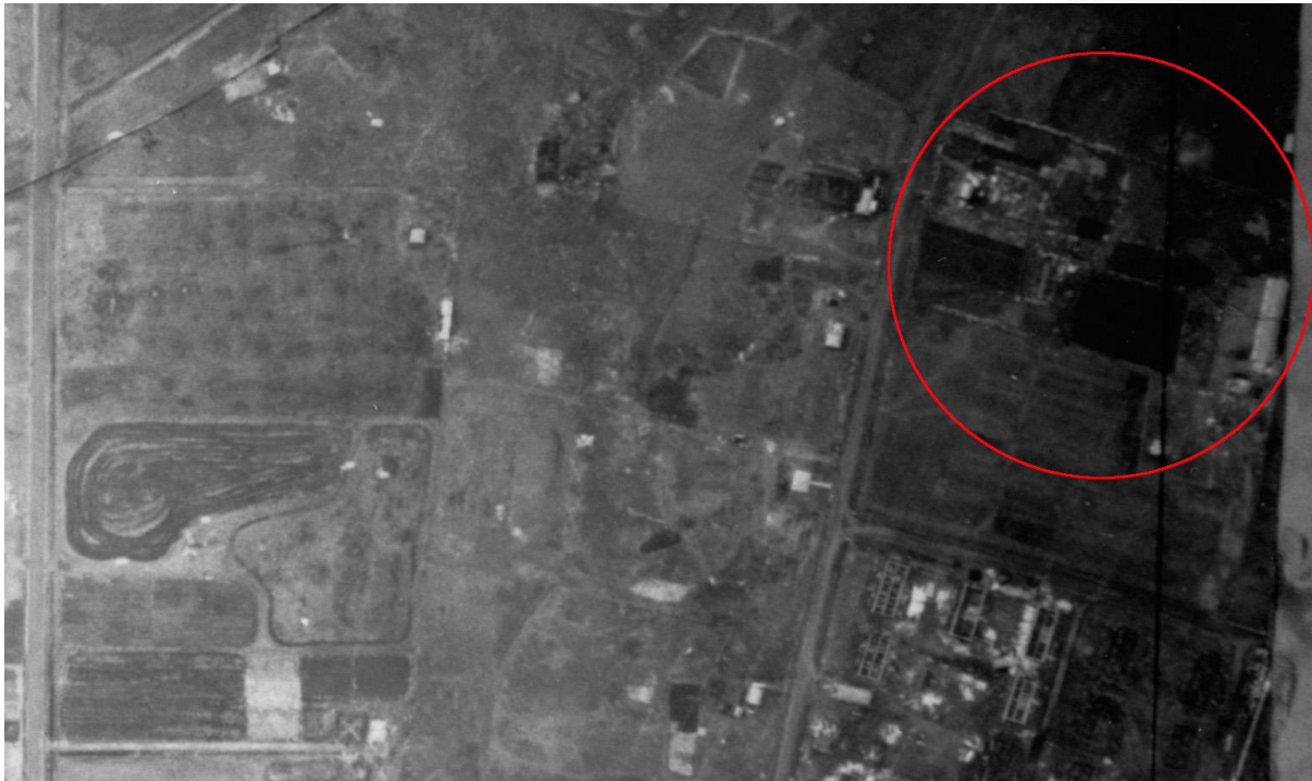
Mynd 5. Svæðið á loftmynd frá 1948-1950. Sogamýrarblettur 47 er innan rauða hringins. Greina má hús fremst eða syðst á blettinum, líklega vinnuskýli Gunnars Vernharðssonar sem byggt var 1945, og hæsnahús sem Einar M. Einarsson byggði 1946 við norðurmörk landsins. 11
