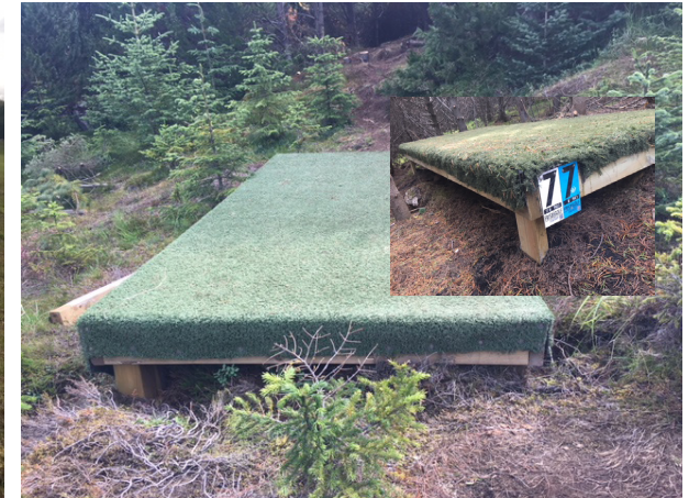
Trépallur. Akkerisstaurar steiptir niður á fjórum hornum.
