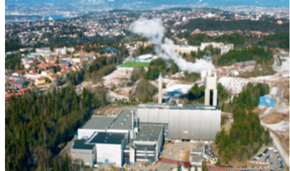
MYND 5 Klemetsrud Waste-to-Energy plant, Noregur. Gangsett: 1986. Stærð: 360.000 tonn á ári, 47 t/klst. Framleiðsla: 150 GWh/ár rafmagn, 700 GWh/ár varmi
