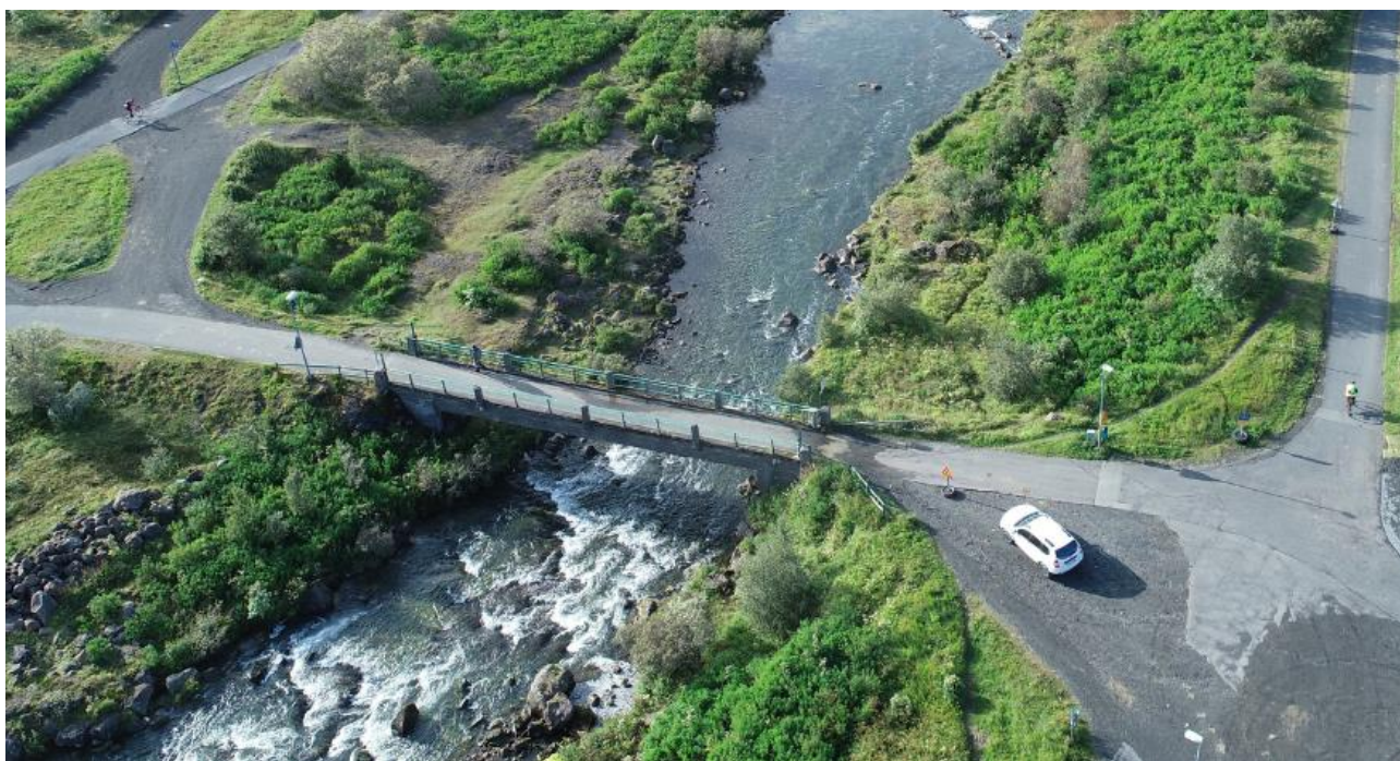
Mynd 10. Gamla vatnsveitubrúin
