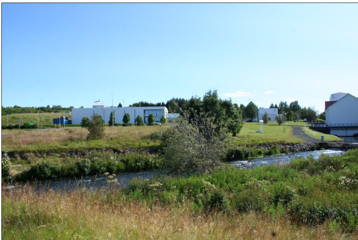
Mynd 76 Ártúnsvað (263-15), horft í austur. Búið er að hlaða upp árbakkana.
