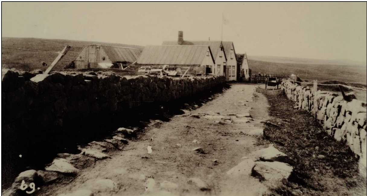
Mynd 85 Árbær um 1923-30, lengst til vinstri er hlaða (262-5) sem fauk 1949 og var ekki endurbyggð. 223 Sjá má að langveggir hlöðunnar eru hlaðnir úr grjóti og flaggstöng er á annarri burstinn.
