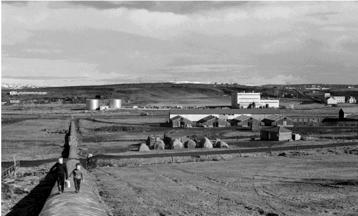
Mynd 11. Horft í austur eftir Reykjaæðinni (1978-4). Þvert yfir myndina liggur Breiðholtsvegur (1978-10). Austan vegarins eru tvö lítil hús (1978-5 og 1978-6) sem stóðu á Sogamýrabletti 24. Við annað þeirra er búið að koma fyrir útiheyi. Enn austar eru hesthús Fáks sem voru rifin (1978-9) og fjær eru olútankar kyndistöðvar, Toppstöðin og Elliðaárstöðin. 17
