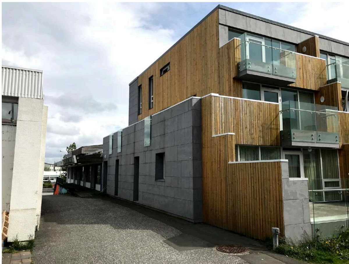
Mynd 12. Eddufell 8 í dag (2020). Nýtt íbúðarhús hefur risið á grunni gamla KRON við Eddufell 8. Klæðning á útveggi hússins er blanda af timbri, steinflísum og gleri. 48
