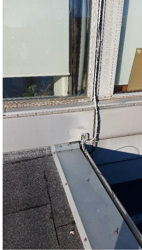
Mynd 6: Opið rafmagn á þaki 1. hæðar
