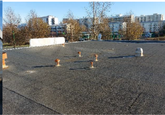
Mynd 2: Þak 1. hæðar, ryðgaðar lofttúður
