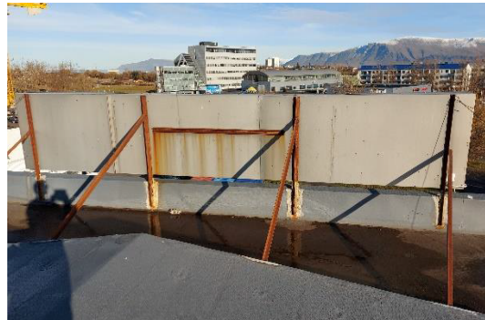
Mynd 12: Ryðgaðar festingar á þaki 1. hæðar
