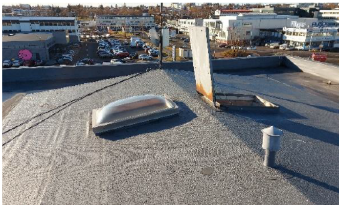
Mynd 3: Þak 3. hæðar
