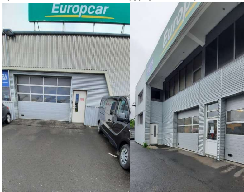
Mynd 1.3. Inngangur inn í þvottasal á austurhlið byggingar á mynd til vinstri og inngangur inn í dekkjaverkstæði á norðurhlið byggingar hægra megin.
