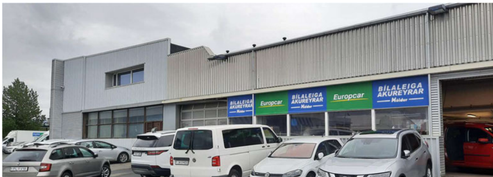
Mynd 3.3. Ál- og aluzink klæðning byggingar.
