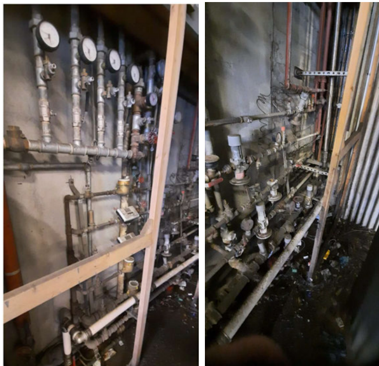
Mynd 2.2. Hitaveitulagnagrind.
