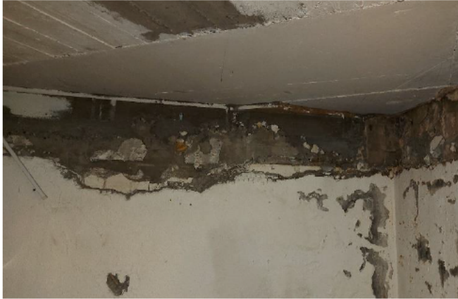
Mynd 17: Rakaskemmdir á kjallaravegg
