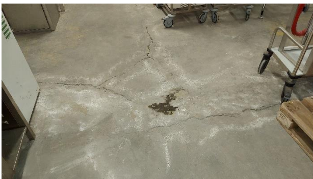
Mynd 15: Raka úrfellingar og sprungur í botnplötu í kjallara
