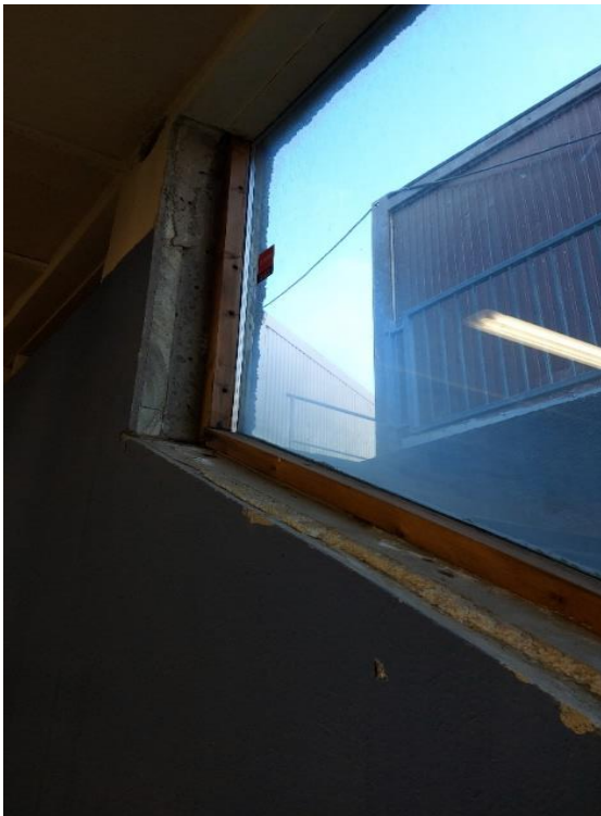
Mynd 11: Ónýtur gluggi í kjallara, rakaskemmd undir glugga
