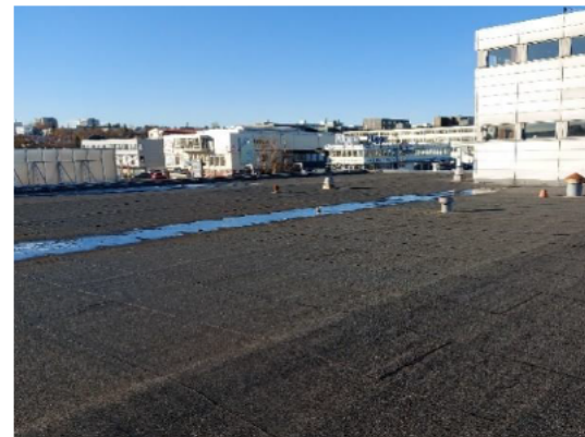
Mynd 4: Þak 1. hæðar
