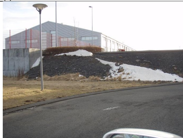
Mynd nr. 4. Aðeins kantsteinn tekur á móti bílum við enda á bílastæðum vestast á bílplani sunnan við Norðurhús. Það tekur við há brekka ef bílar fara yfir kantsteininn. Lagt er til að gerður verði veggur við enda bílplans. (2)
