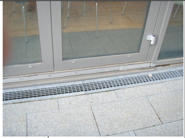
Mynd nr. 6. Állista vantar undir hurð frá mötuneyti. Setja þarf hann upp að nýju. (1)
