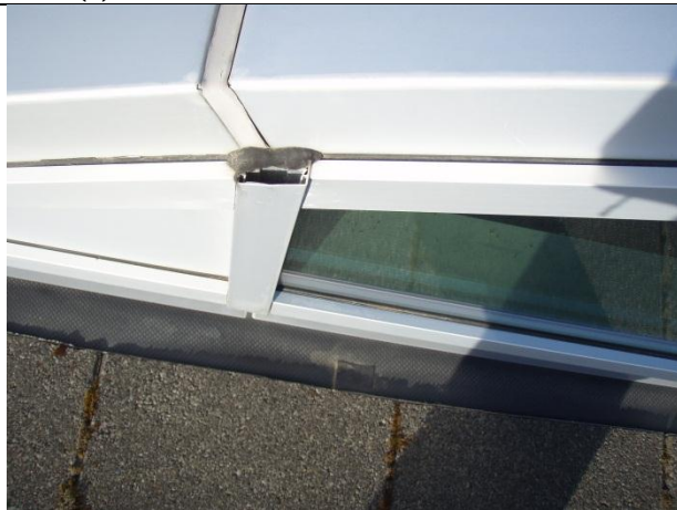
Mynd nr. 5. Lóðréttir þéttlistar á austurgafli glerhjúps eru opnir að ofanverðu og því á vatn greiðan leið þar inn. Loka þarf listunum að ofan. (1)
