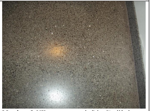
Mynd nr. 6. Víða eru sprungur í yfirborði gólfa á göngubrum. Ekki er talið þörf á að gera við þetta í náninni framtíð.
