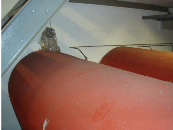
Mynd nr. 3. Flóðavörn vantar í kringum hitaveitupípur við stokkenda sem tengjast stöðinni. (1)
