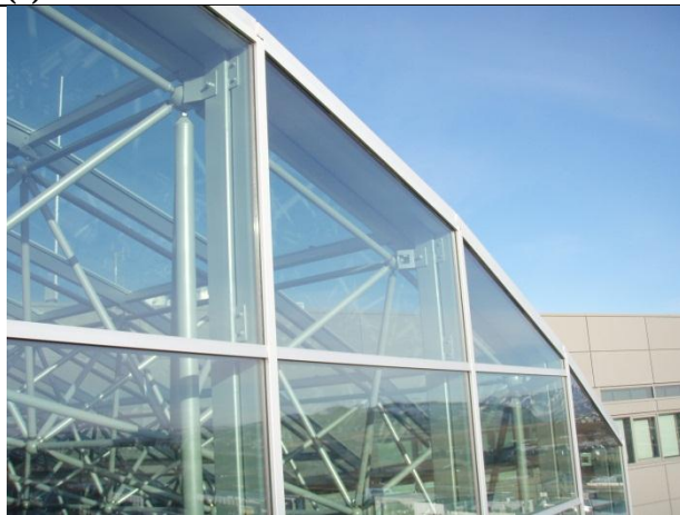
Mynd nr. 3. Tveir lóðréttir þéttlistar hafa sigið niður nyrst á austurhlið glerhjúps. Lyfta þarf þeim upp aftur og festa. (1)
