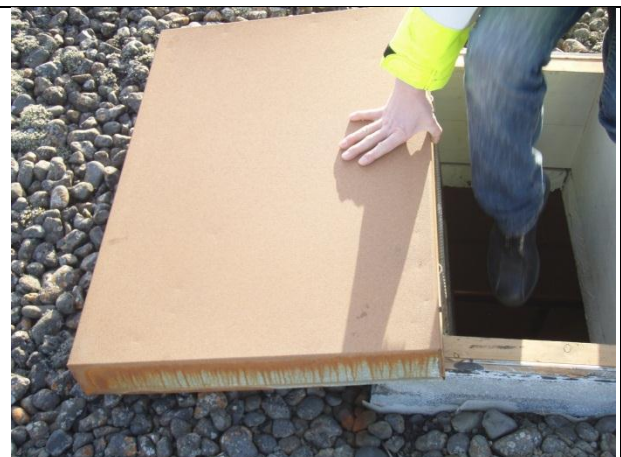
Mynd nr. 2. Blikklok á mannopi upp á þak er ryðgað og þarf að mála það. (2) Einnig er lokið laust að sunnanverðu frá krossviðarplötunni undir henni. Festa þarf blikklokina sem fyrst til að það fjúki ekki af. (1)
