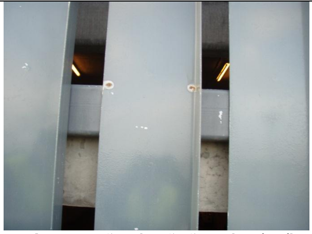
Mynd nr. 4. Ryð er byrjað að myndast á málm-klæðningu á norðurhlið bílageymslunnar. Einkum út frá suðum og víða. Mála þarf klæðninguna innan tíðar. (3)
