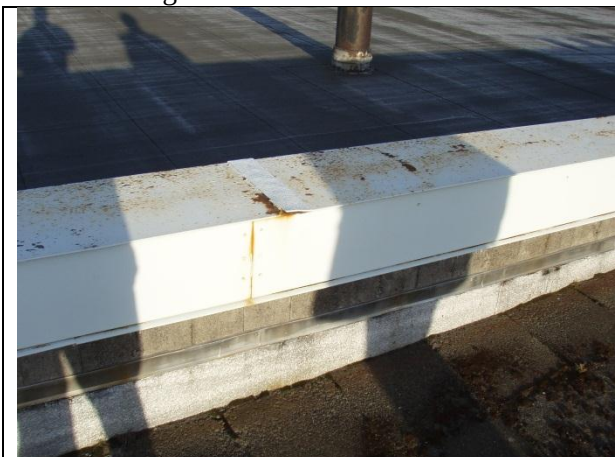
Mynd nr. 1. Steiptur veggur sem gengur upp úr þaki stöðvarinnar er klæddur með blikk áfellu sem er byrjuð að ryðga. Mála þarf áfelluna. (2)*
