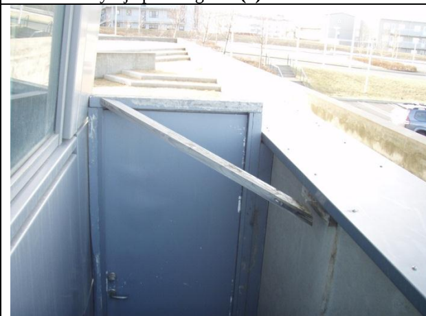
Mynd nr. 3. Bráðabirgða timburhurð sem sett var fyrir stiga upp á þak utan við 1. hæð að vestan er laus. Laski hefur rífið sig lausan. Setja þarf varanlega hurð hér. (1)
