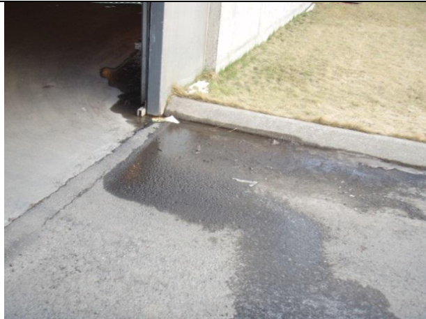
Mynd nr. 3. Allt vatn úr rampa framan við innkeyrslu-hurðina rennur inn undir hurðina og eftir bílageymslunni að niðurfalli sem er við næstu súlu. Setja þarf svelg utan við hurðina. (1)
