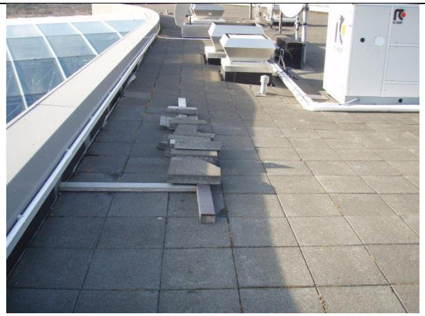
Mynd nr. 2. Hellur liggja ofan á timburbita ofan á hellulögn þaks. Ekki er ljós tilgangurinn með þessu. Fjarlægja þarf þetta af þakinu. (1)
