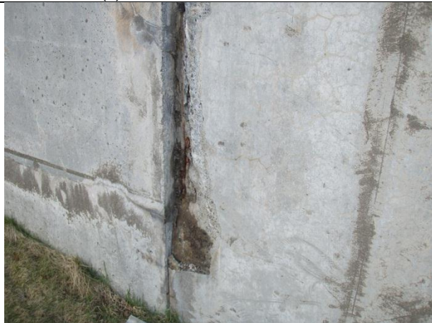
Mynd nr. 5. Stór múrskemmd er í suðausturhorni bíl-geymslunnar. Gera þarf við þessa skemmd og ganga frá steypuskilum með áláfelli yfir. (1)
