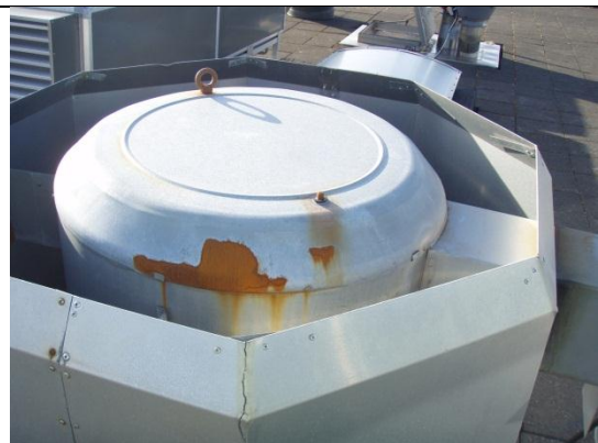
Mynd nr. 6. Hífilykkju vanta á mótör og ryð er byrjað að koma efst á mótör. Setja þarf hífilykkju og mála mótör. (2)
