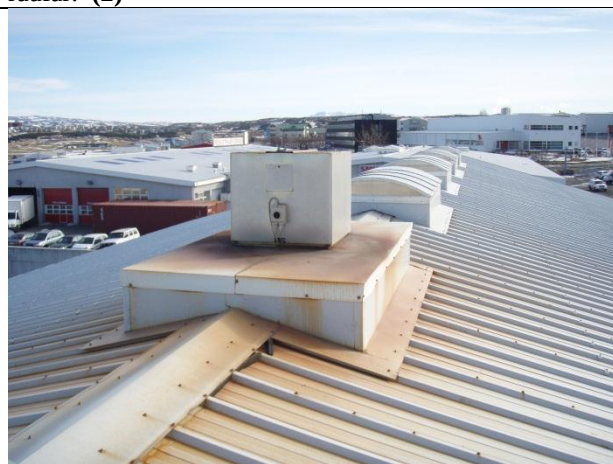
Mynd nr. 3. Ryð er komið í langsamskeyti, skráfur og víða á þaki Norðurhús. Mála þarf þakið innan 2-3 ára. (2)
