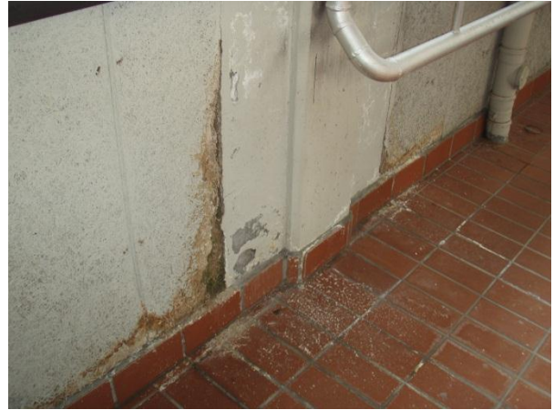
Mynd nr. 4. Lekaskemmdir eru á vegg milli efri og neðri gólfplötu. Setja þarf upp dælubrunn til að lækka vatnsstöðuna. (2)
