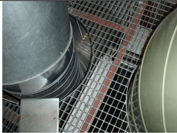
Mynd nr. 5. Stórar rifur eru milli rimlagólfa og röra víða í lagnasköftum Vesturhúss. Fella þarf plötur yfir þessi göt. (1)
