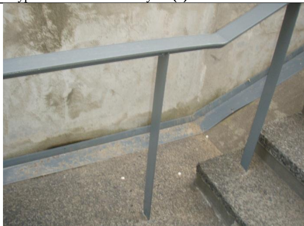
Mynd nr. 7. Áfellur milli húss og stiga eru ekki þéttar. Yfirfara þarf þær og laga. (1)
