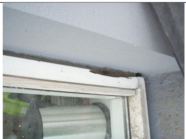
Mynd nr. 4. Þéttingar vantar í kringum hurðir og glugga sem eru í steypum útveggjum á jarðhæð hússins. Yfirfara þarf þessar þéttingar. (2)
