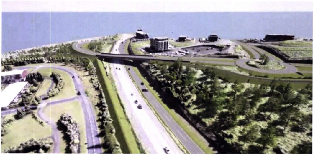
Mynd 8.4 Horft austur eftir Breiðhóltsbraut yfir vegamót við Arnarnesveg (skjáskot úr myndbandi, Efla 2020).
