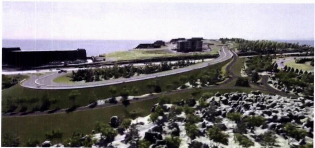
Mynd 8.3 Horft frá efsta hluta Elliðaárdals til suðurs yfir vegamót Arnarnesvegur og Breiðholtsbrautar (skjáskot úr myndbandi, Efla 2020).
